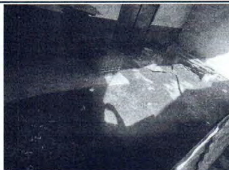
FOTO 6: SE OBSERVA PARTES DE CONCRETO Y PARTES DE TIERRA, ES NECESARIO UNA PLANCHA DE CONCRETO.
