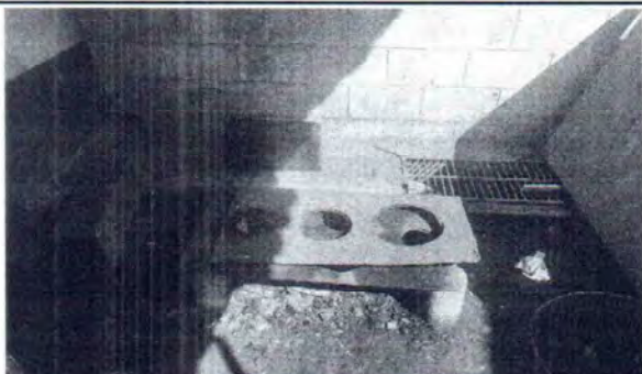
FOTO 3: SE OBSERVA LA ESTUFA IMPROVISADA PARA COCINAR LOS ALIMENTOS, URGE LA CONSTRUCCIÓN DE UNA FORMAL.
