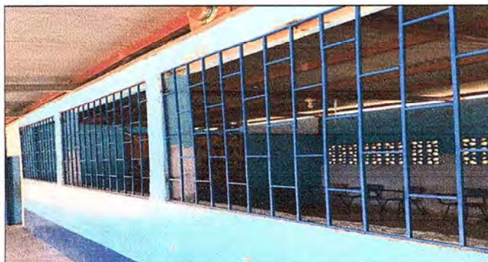
Foto 7: Se observa los balcones totalmente ya instalados.
