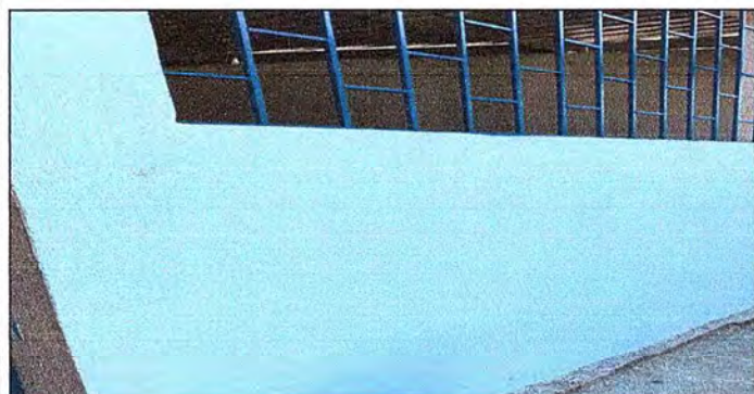
Foto 11: Se observa la aplicación de cernido monocapa totalmente terminado.
