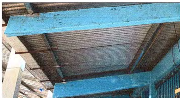
Foto 4: Se observa completamente la sustitucion de estructura portante de metal terminado.
