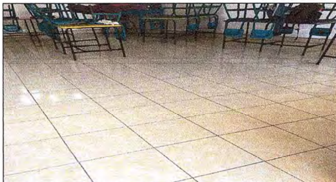
Foto 8: Se observa la instalacion del piso ceramico terminado.
