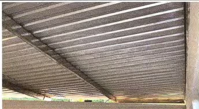
Foto 2: Se observa la instalacion de estructura portante de metal terminado.
