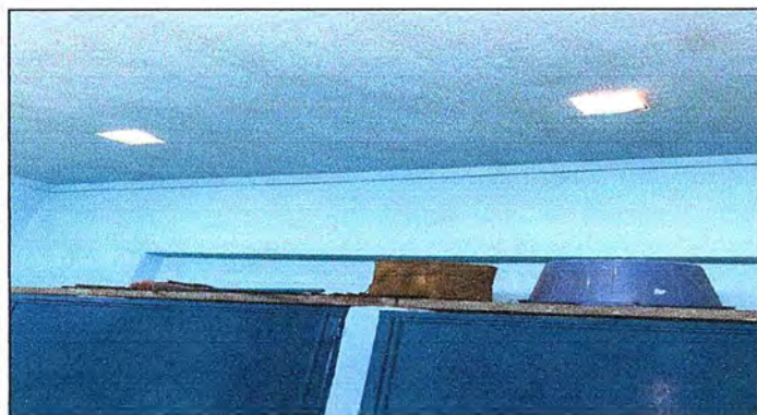
Foto 09: Se observa el proceso de reparación de losa con impermeabilizante.
