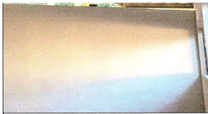
Foto 6: Se observa repello monocapa de paredes terminado.
