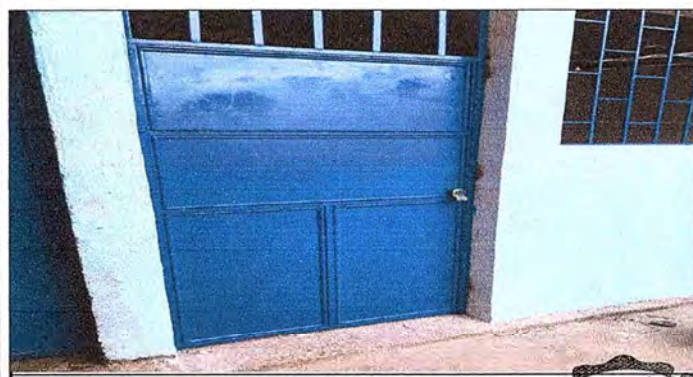
Foto 5: Se observa la instalacion de puerta de metal terminado.
