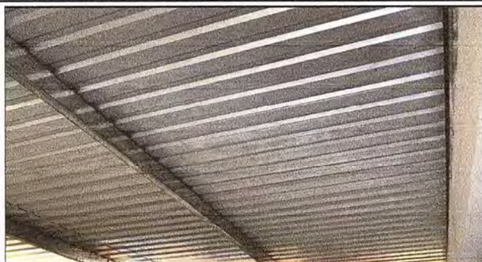
Foto 1: Se observa el techo, instalacion de lamina completamente terminado.
