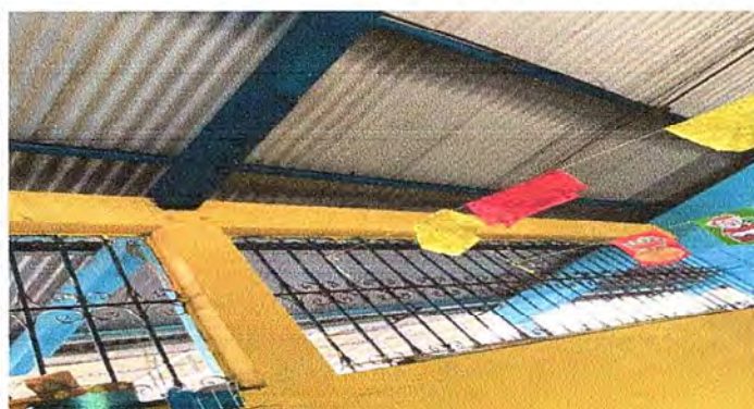
Foto 3: Se observa terminado el mantenimiento de la estructura portante de metal.
