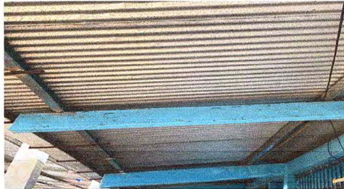
Foto 4: Se observa el proceso de sustitucion de estructura portante de metal.
