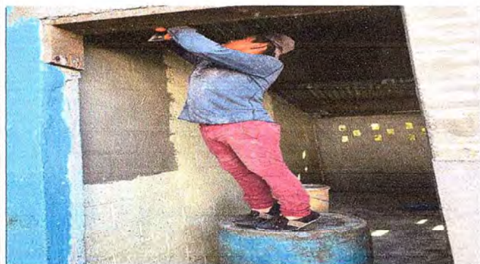
Foto 11: Se observa la aplicación de cernido monocapa.
