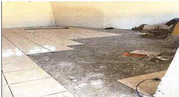
Foto 8: Se observa el proceso de instalación del piso cerámico.
