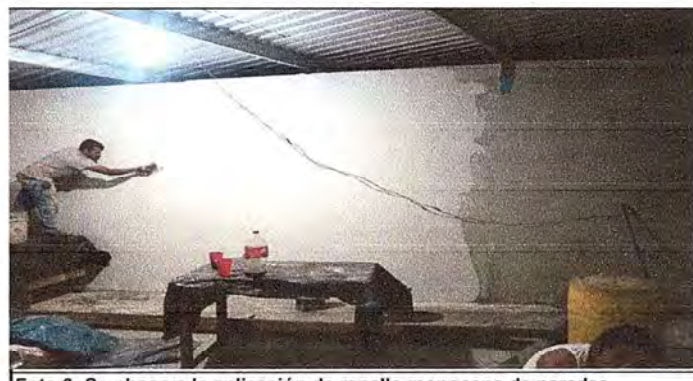
Foto 6: Se observa la aplicacion de repello monocapa de paredes.
