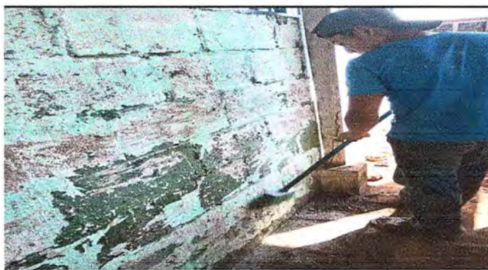
Foto 10: Se observa los procesos de resane de muros
