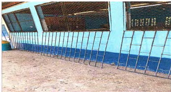
Foto 7: Se observa los procesos de elaboración e instalación de balcones.
