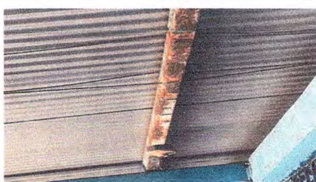
Foto 4: Se observa la necesidad de sustituir estructura de metal por metal.
