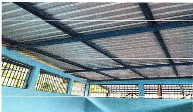
Foto 1: Se observa que, en el módulo de aulas se sustituyó laminas.
