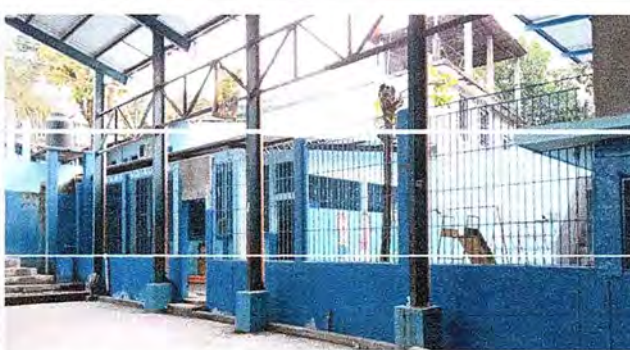
Foto 6: Se observa que se sustituyó barandas de metal por malla.
