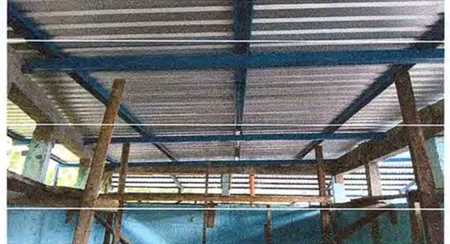
Foto 2: Se observa que se está realizando el cambio de la estructura de soporte de madera por metal.
