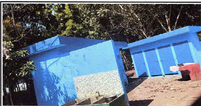
Foto 11: SE LE HA REALIZADO MANTENIMIENTO Y PINTURA A LAS PAREDES DE LOS BAÑOS, CON PINTURA ACRILICA
