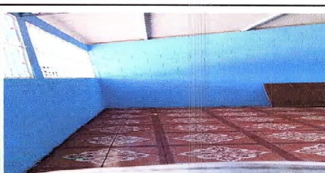
Foto4: SE OBSERVA QUE LA PINTURA DE LAS PAREDES DE LAS AULAS YA HAN SIDO PINTADAS.
