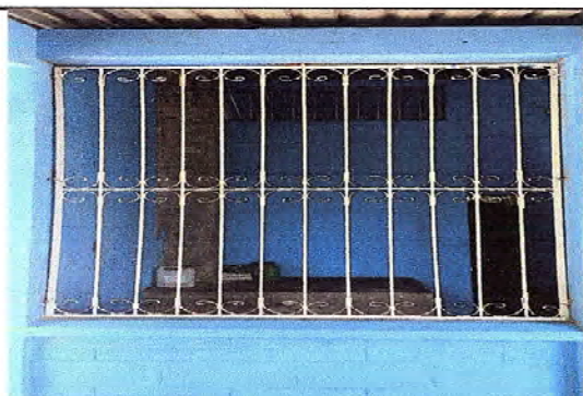
Foto 9: SE SUSTITULLO EL BALCON DE LA COCINA.
