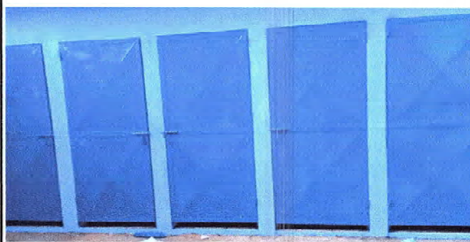
Foto 10: SE OBSERVA QUE SE HAN PINTADO Y DADO MANTENIMIENTO A LAS PUERTAS DE LOS BAÑOS.
