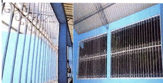
Foto 2: SE OBSERVA QUE LOS BALCONES DE METAL YA SE LES DIO EL MANTENIMIENTO CON PINTURA ANTICORROSIVA.
