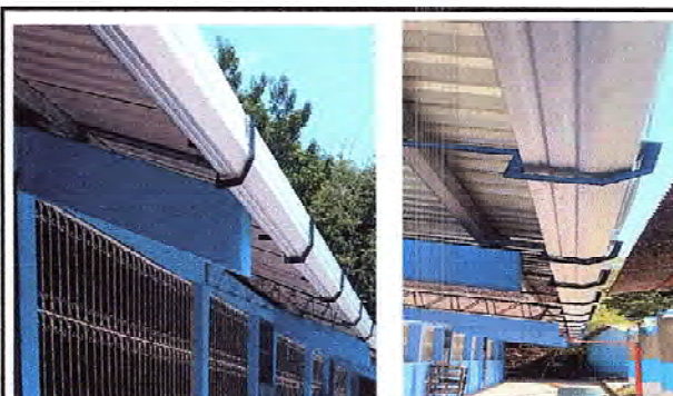
Foto 12: SE HA INSTALADO SUMINISTRO DE CANAL DE METAL CON VAJADA PLUVIAL EN AMBOS LADOS.
