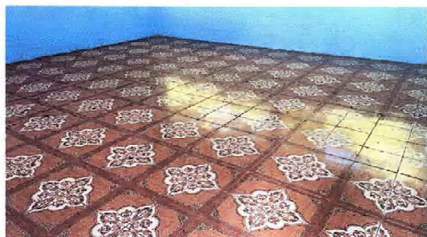
Foto 1: SE OBSERVA QUE EL PISO DE CEMENTO HA SIDO REMPLAZADO, POR PISO CERAMICO.
