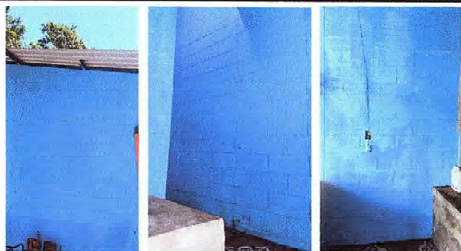
Foto 7: SE OBSERVA QUE SE HAN PINTADO EL AREA DE COCINA.
