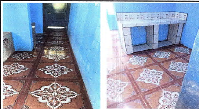
Foto 8: SE HA SUSTITUIDO CON PIZO CERAMICO EN LA COCINA.
