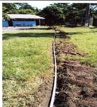
Foto 13: SE LE DA REMOZAMIENTO A LA LINEA PRINCIPAL DE TUBERIA PVC DE AGUA POTABLE ENTRADA.
