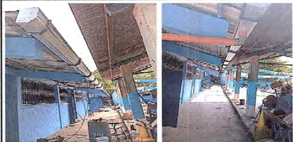
FOTO 12. SE OBSERVA QUE SE ESTÁ INSTALANDO CANAL DE METAL CON SU BAJADA PLUVIAL.
