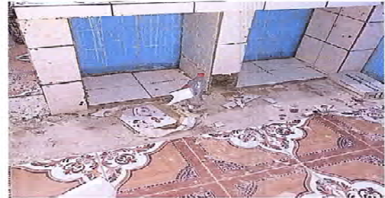
FOTO 8. SE OBSERVA QUE EL PISO DE COCINA ESTA SIENDO SUSTITUIDO POR CERAMICO.
