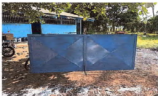
Foto3: SE OBSERVA QUE LAS PUERTAS DE LAS AULAS ESTÁN RECIBIENDO MANTENIMIENTO.
