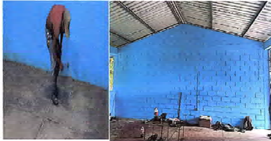
FOTO 7. SE OBSERVA QUE LAS PAREDES DE LA COCINA ESTAN SIENDO PINTADAS.
