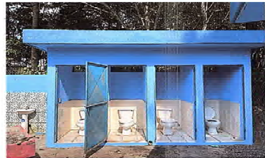
FOTO 10. SE OBSERVA QUE LAS PUERTAS DEL BAÑO ESTÁN SIENDO DESINSTALADAS PARA BRINDAR EL DEBIDO MANTENIMIENTO.
