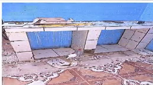
Foto5: SE OBSERVA QUE ESTÁN TRABAJANDO EN EL MUEBLE DE COCINA.
