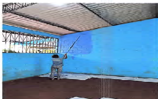
Foto4: SE OBSERVA QUE LAS PAREDES DEL AULA ESTÁN SIENDO PINTADAS.
