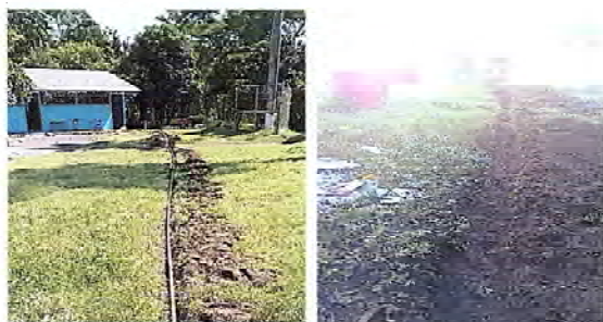
FOTO 13. SE OBSERVA QUE LA LINEA PRINCIPAL DE TUBERIA DE PVC ESTÁ SIENDO SUSTITUIDA.
