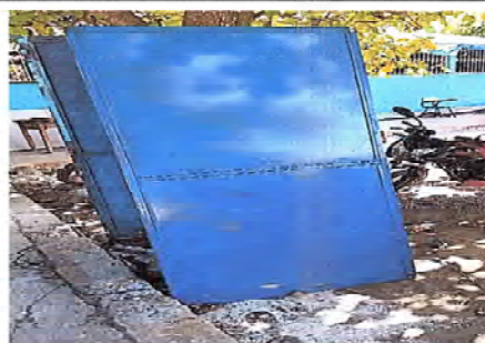
Foto6: SE OBSERVA QUE LAS PUERTAS DE COCINA ESTÁN RECIBIENDO MANTENIMIENTO.
