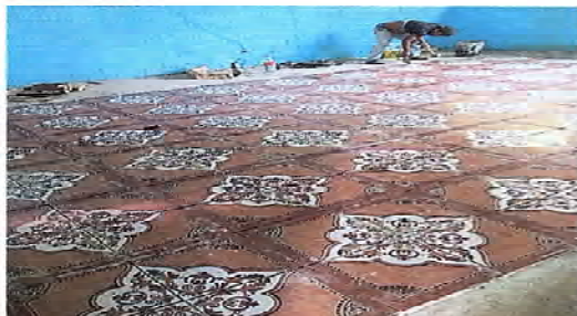
Foto 1: SE OBSERVA QUE EL PISO DE CEMENTO ESTA SIENDO SUSTITUIDO POR PISO CERAMICO.
