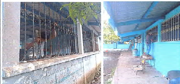
Foto 2: SE OBSERVA QUE LOS BALCONES DE METAL ESTÁN RECIBIENDO MANTENIMIENTO.
