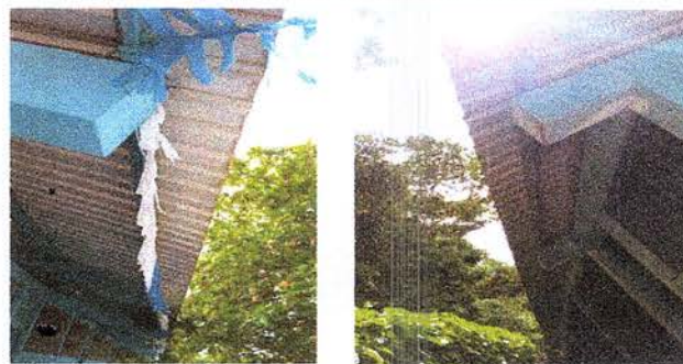
FOTO 12. SE OBSERVA QUE SE NECESITA SUMINISTRO DE CANAL DE METAL CON BAJADA PLUVIAL EN AMBOS LADOS DEL MODULO DE AULAS.
