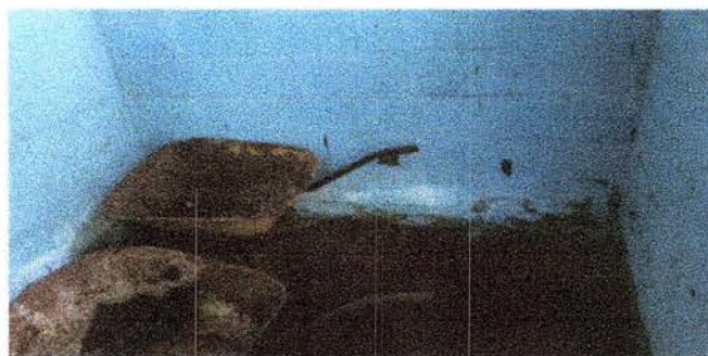
Foto 5: SE OBSERVA QUE NO SE CUENTA CON MUEBLE DE COCINA.
