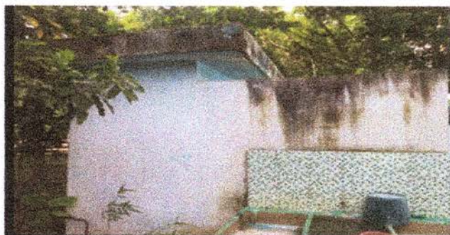
FOTO 11. SE OBSERVA QUE LA PINTURA EN PAREDES DE LOS BAÑOS REQUIEREN MANTENIMIENTO URGENTE CON PINTURA ACRILICA.
