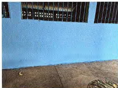
Foto 13: Se observa paredes del exterior de aula pintadas
