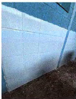
Foto 3: Se observa azulejo nuevo instalado en cocina
