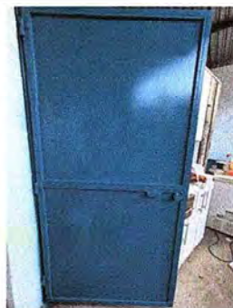
Foto 4: se observan puerta nueva instalada
