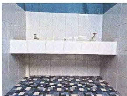
Foto 12: Se observa lavamanos reparado
