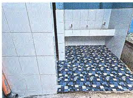
Foto 15: Se observa azulejo nuevo instalado
