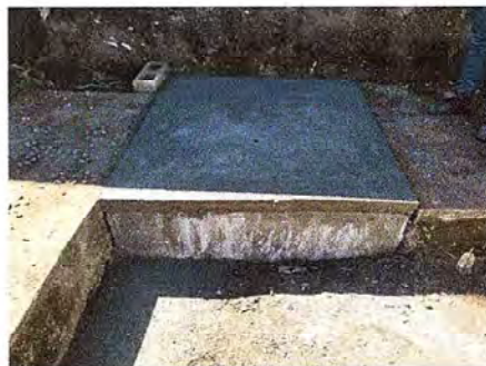
Foto 14: Se observa sumidero terminado
