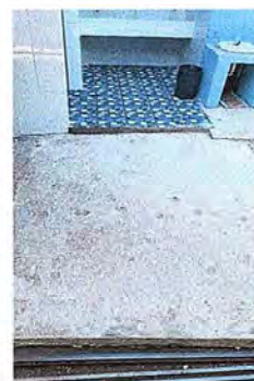
Foto 16: Se observa proceso de fundición de losa en baños
