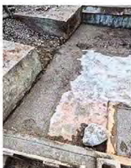
Foto 9: Se observa tubería de pvc pluvial instalada y fundida
