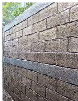
Foto 10: Se observa muro reparado.
