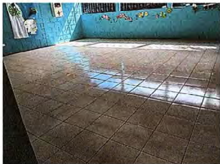
Foto 1: Se observa piso nuevo instalado
