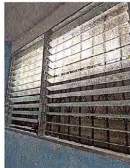
Foto 2: Se observan ventanas nuevas instaladas
