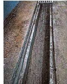
Foto 6: Se observa proceso cuneta de concreto finalizada
