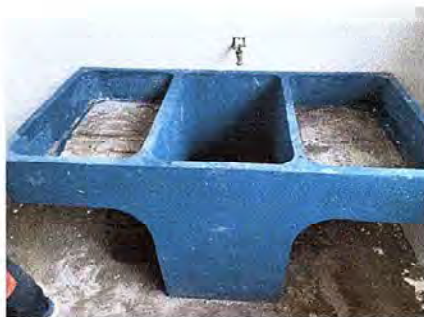
Foto 5: Se observa pila nueva instalada
