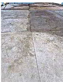
Foto 11: Se observa torta de concreto reparada
