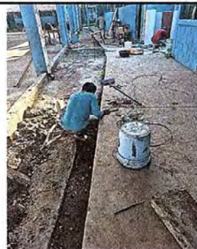
Foto 6: Se observa proceso fabricación de cuneta de concreto
