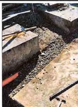
Foto 9: Se observa proceso de instalación de tubería agua pluvial
