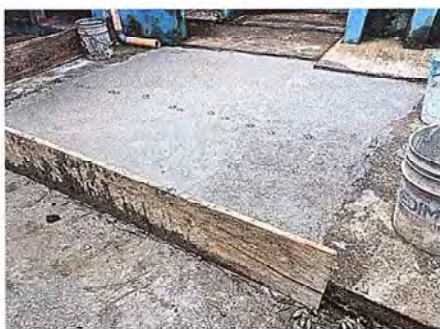
Foto 16: Se observa proceso de fundición de losa en baños
