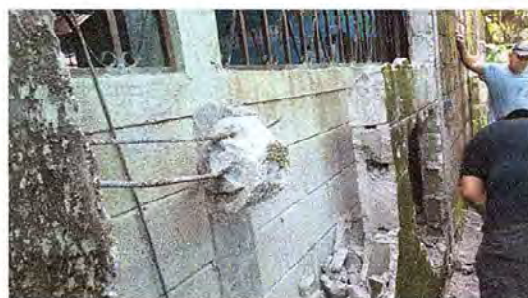
Foto 10: Se observa proceso de derribo de muro para levantamiento nuevo
