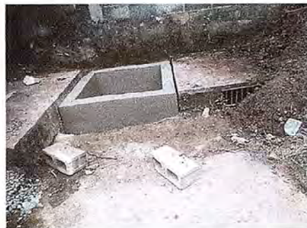
Foto 14: Se observa proceso de fundición de paredes sumidero
