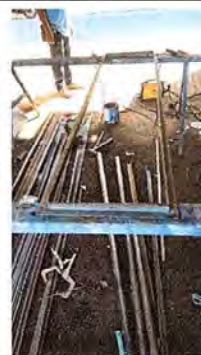
Foto 8: Se observa proceso de elaboración de rejilla
