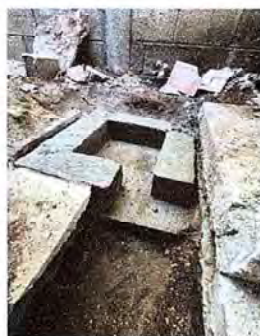
Foto 7: Se observa proceso de elaboración de caja de registro
