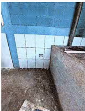
Foto 3: Instalación de azulejo nuevo
