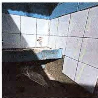
Foto 15: Se observa proceso de instalación de azulejo
