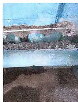
Foto 12: Se observa proceso de cambio de lavamanos de concreto y azulejo
