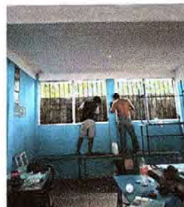
Foto 2: Se observa proceso de instalación de ventanas nuevas
