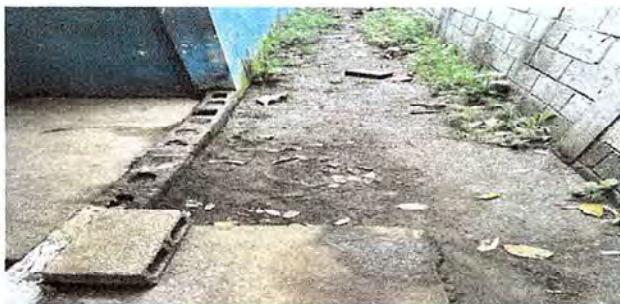
Foto 7: Se observa que allí se instalará la caja de registro.
