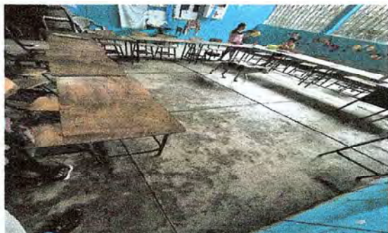
Foto 1: Se observa el deterioro del piso de concreto el cual será sustituido por cerámico.
