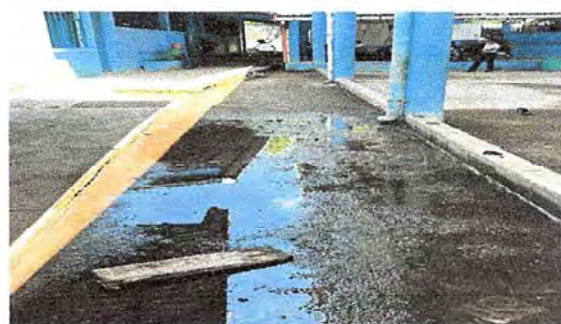
Foto 6: Se observa que el patio no tiene cuneta para drenar el agua.
