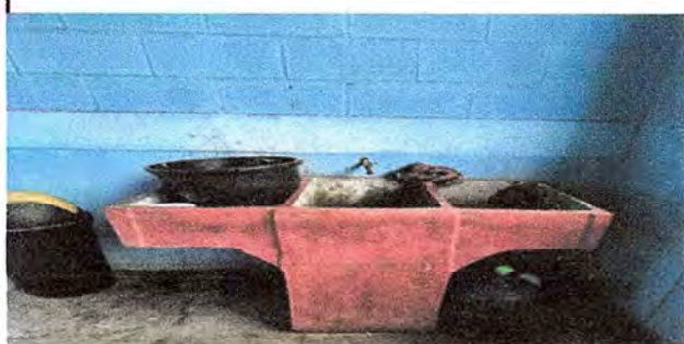
Foto 5: Se observa que las dimensiones de la pila es muy pequeña para el uso diario de cocina.
