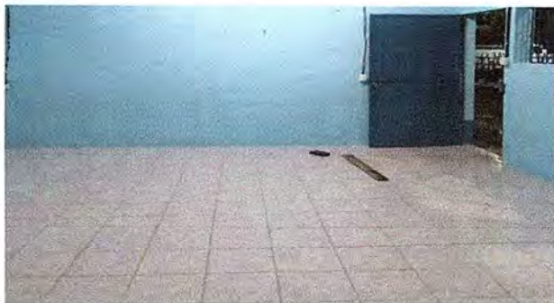
Foto 7: SE OSERVA YA INSTALADO EL PISO.
