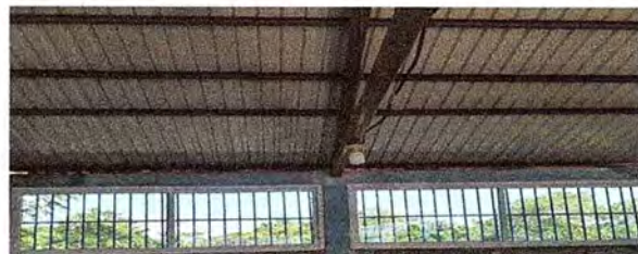
Foto 8: MODULO 3 SE OSERVA TERMINADO LA INSTALACION DE VENTANAS DE PVC.
