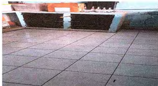
Foto 12: SE OSERVA YA INSTALADO EL DE PISO CERAMICO
