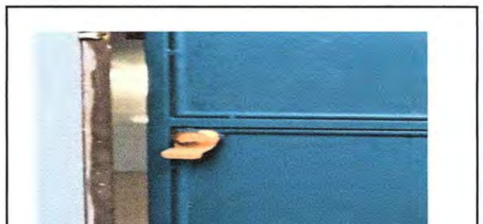
Foto 6: SE OBSERVA LA INSTALACION DE CHAPA
