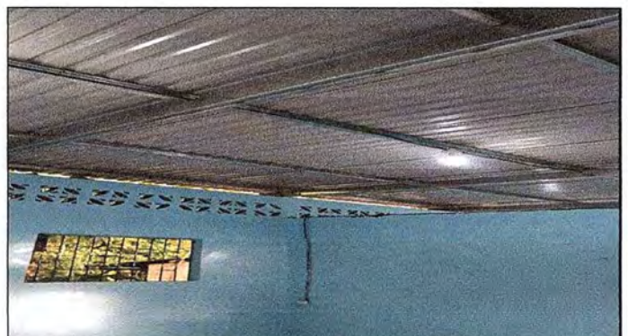
Foto 4: SE OBSERVA TOTALMENTE EL CAMBIO DE TECHO.
