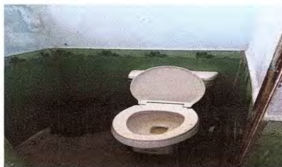
Foto 10: SE OSERVA YA REPARADO LOS SANITARIOS.
