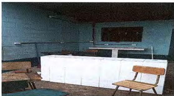
Foto 9: SE OSERVA LA RED ELECTRICA YA TERMINADA.
