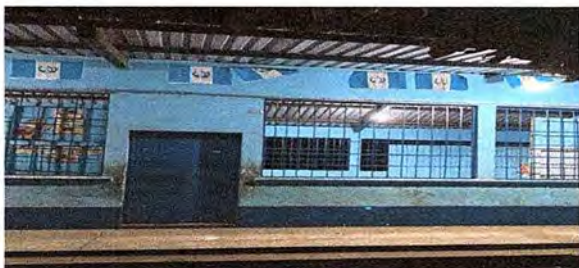
Foto 11: SE OSERVA YA INSTALADOS LOS BALCON
