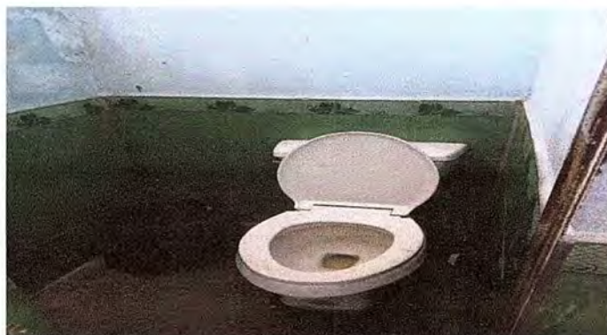
Foto 10: SE OSERVA LA REPARACION DE SANITARIOS.
