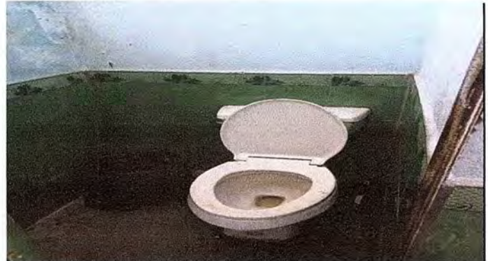
Foto 10: SE OSERVA LA REPARACION DE SANITARIOS.
