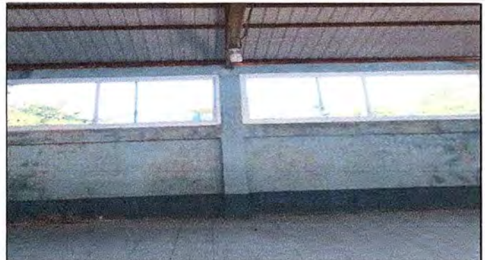
Foto 8: MODULO 3 SE OSERVA EL PROCESO DE INSTALACION DE VENTANAS DE PVC.
