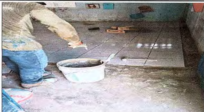
Foto 7: MODULO 3 SE OSERVA EL PROCESO DE REPARACION DE PISO.
