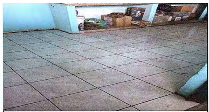
Foto 12: SE OSERVA EL PROCESO DE CAMBIO DE PISO CERAMICO
