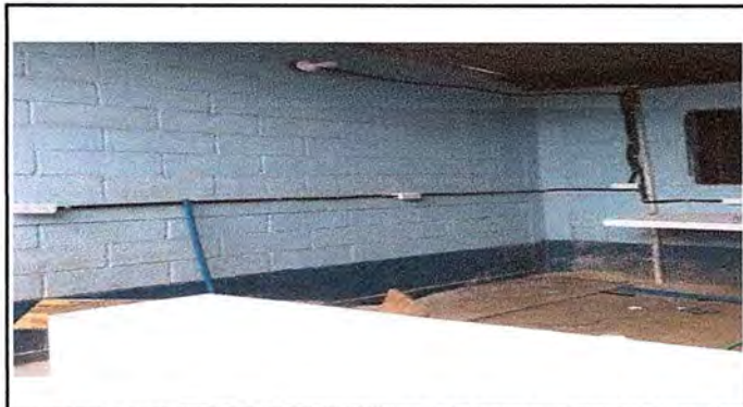
Foto 9: SE OSERVA EL PROCESO DE INSTALCION DE RED ELECTRICA.
