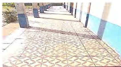
FOTO 2: SE OBSERVA QUE EL PISO CERÁMICO YA FUE INSTALADO.
