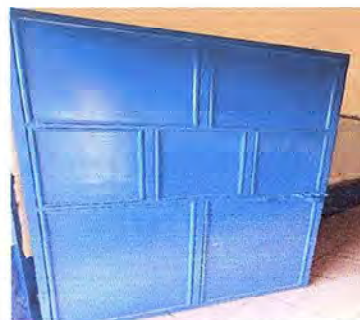
FOTO 4: SE OBSERVA QUE LA PUERTA DEL MÓDULO 2 YA RECIBIO SU MANTENIMIENTO.
