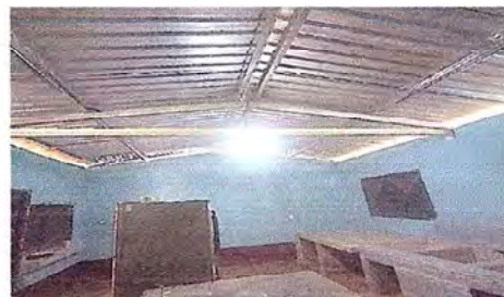
FOTO 6: SE OBSERVA QUE LA ESTRUCTURA DE METAL YA FUE INSTALADA.
