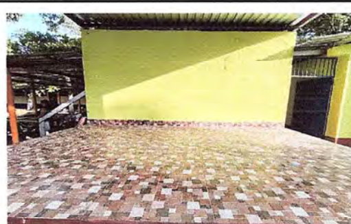
FOTO 8: SE OBSERVA QUE ESTÁN CAMBIANDO EL PISO DE CONCRETO POR CERÁMICO..
