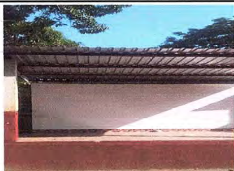
FOTO 7: SE OBSERVA QUE LA PARED DEL FONDO DEL ESCENARIO YA CUENTA CON CERNIDO Y REPELLO.
