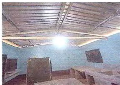
FOTO 5: SE OBSERVA QUE LA LÁMINA DE LA COCINA YA FUE INSTALADA.
