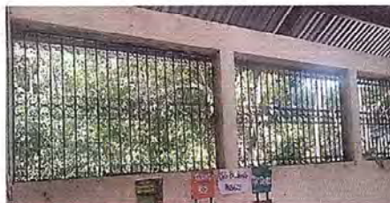
FOTO 1: SE OBSERVA QUE YA FUE INSTALADO EL BALCON
