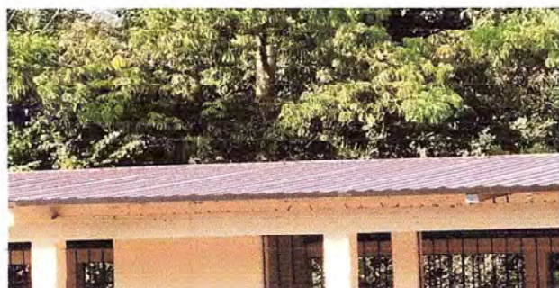
FOTO 3: SE OBSERVA QUE LA LÁMINA YA RECIBIO SU MANTENIMIENTO.
