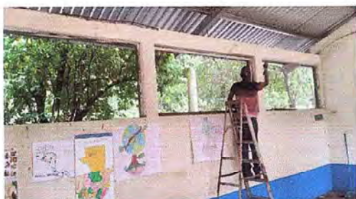
FOTO 1: SE OBSERVA QUE ESTÁN TRABAJANDO EN LAS VENTANAS.
