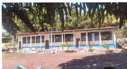
FOTO 3: SE OBSERVA QUE ESTÁN TRABAJANDO EN LÁMINAS.
