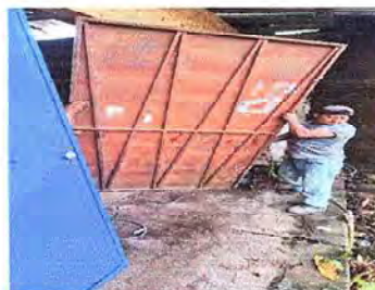
FOTO 4: SE OBSERVA QUE ESTÁN REALIZANDO MANTENIMIENTO DE LA PUERTA.
