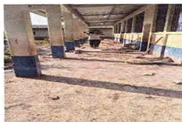
FOTO 2: SE OBSERVA QUE ESTÁN TRABAJANDO EN COLOCAR PISO DE GRANITO
