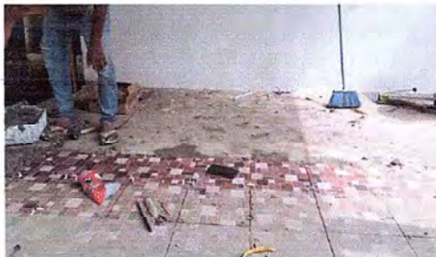
FOTO 8: SE OBSERVA QUE ESTÁN CAMBIANDO EL PISO DE CONCRETO POR CERÁMICO.
