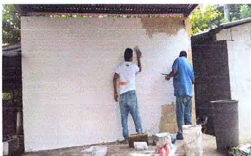
FOTO 7: SE OBSERVA QUE ESTÁN TRABAJANDO EN LA PARED DEL FONDO DEL ESCENARIO.
