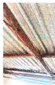
Foto 6: Se observa que en la cocina se cuenta con estructura de madera y esta presenta polilla, debe cambiarse por estructura de metal.
