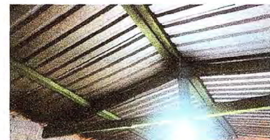
Foto 5: Se observa que la lámina en la cocina ya presenta agujeros, por lo que se necesita que se cambie.
