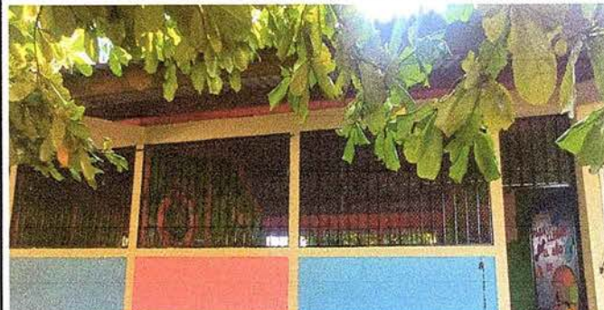
Foto 2: SE OBSERVA QUE LOS BALCONES YA RECIBIERON SU MANTENIMIENTO PREVENTIVO.
