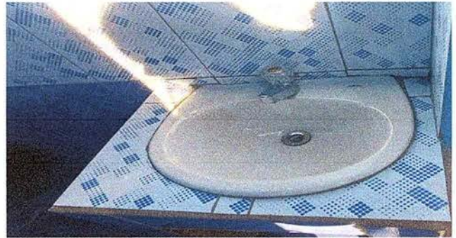
Foto 14: SE OBSERVA QUE EL LAVAMANO YA FUE SUSTITUIDO.
