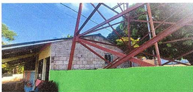
Foto 3: SE OBSERVA QUE FUE CONFORMADO EL MOJINETE DEL MÓDULO 1
