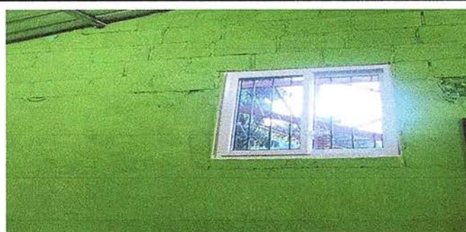
Foto 5: SE OBSERVA QUE SE CONFORMO UNA NUEVA VENTANA PARA TENER BUENA ILUMINACIÓN Y VENTILACIÓN.
