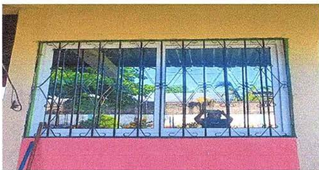
Foto 7: SE OBSERVA QUE SE SUSTITUYO LA VENTANA Y BALCON DE METAL.
