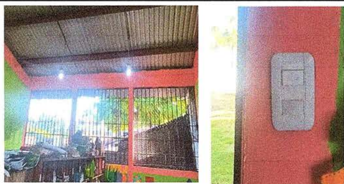
Foto 9: SE OBSERVA QUE EL SISTEMA ELÉCTRICO FUE SUSTITUIDO
