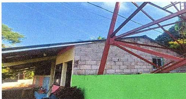
Foto1: SE OBSERVA LOS MÓDULOS 1 Y 2 AULAS REMOZADAS
