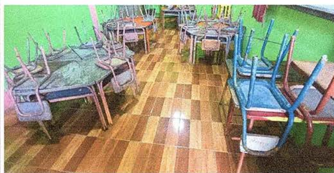
Foto 8: SE OBSERVA QUE SE SUSTITUYO PISO DE CONCRETO POR PISO CERAMICO.
