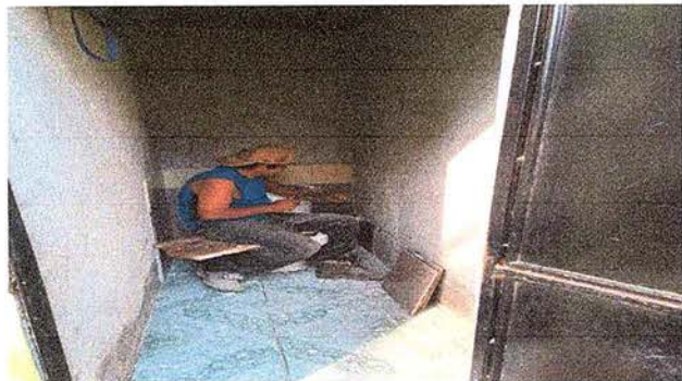
Foto 13: SE OBSERVAN QUE SE ESTA CAMBIANDO EL INODORO QUE SE ENCUENTRA EN MAL ESTADO.
