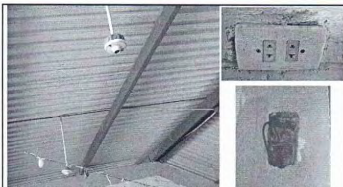
Foto 9: Se observa que el sistema eléctrico, se encuentra en mal estado, urge sustituirlo
