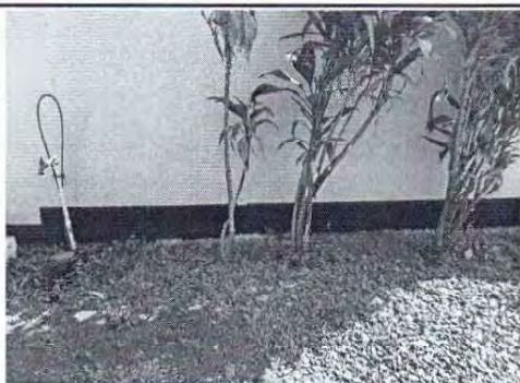
Foto 11: Se observa el grifo en mal estado, el cual debe sustituir con una estación de lavado
