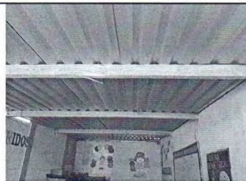
Foto 4: Se observa que la cubierta del módulo de aulas 1, necesita sustitución
