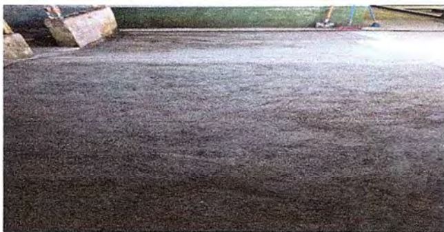
Foto 9: Se observa plancha de concreto finalizada.
