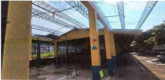
Foto 1: Se observa que la lámina ya fue desmontada para realizar el cambio
