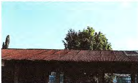
Foto 1: Se observa que la lámina de zinc, se encuentra en mal estado.
