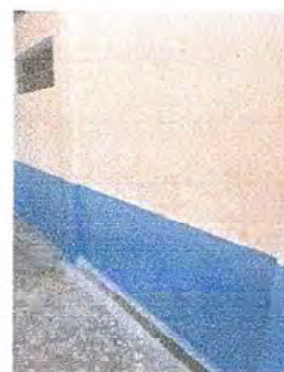
Foto 16: Se observa pared repellada y pintada
