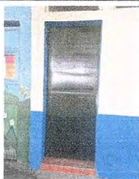
Foto 3: Se observan puertas de acceso a baños nuevas
