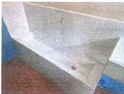
Foto 9: Se observa mingitorio terminado azuleado y con el agua y drenaje conectados
