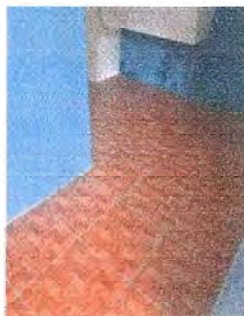
Foto 1: Se observa piso nuevo
