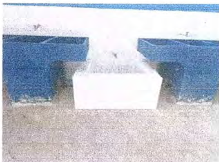
Foto 13: Se observa azulejo nuevo instalado
