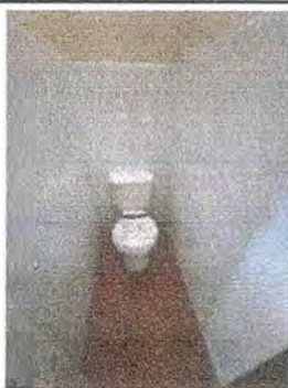
Foto 5: Se observan paredes azulejadas
