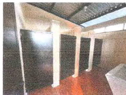
Foto 2: Se observan puertas nuevas instaladas y pintadas
