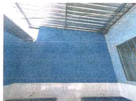
Foto 10: Se observan muro reforzado con soleras y columnas
