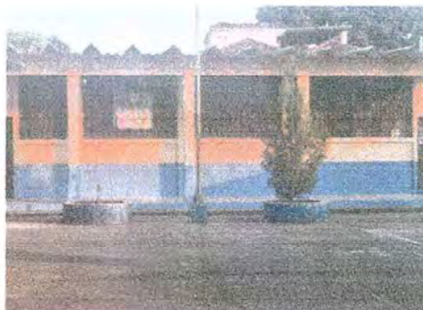
Foto 19: Se observa pintura reciente y en buen estado
