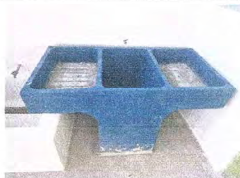
Foto 14: Se observa pila nueva instalada
