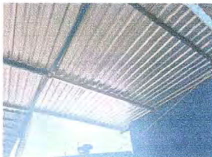
Foto 11: Se observa lámina troquelada nueva instalada
