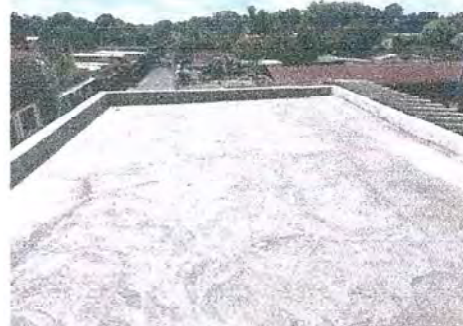
Foto 18: se observa trabajos de impermeabilizado y pañuelos de loza finalizados
