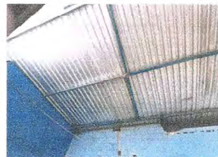
Foto 12: Se observa estructura de soporte de metal nueva
