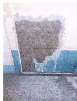
Foto 16: Se observa reparación de repello en pared
