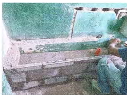
Foto 9: Se observa mingitorio en proceso de armado
