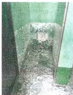
Foto 5: Se observan paredes trabajadas para instalación de azulejo
