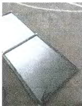
Foto 3: Se observa fabricación de puertas para entrada a los baños
