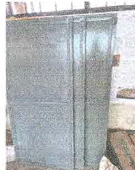
Foto 6: Se observan puertas de sanitarios con mantenimiento previo a instalación
