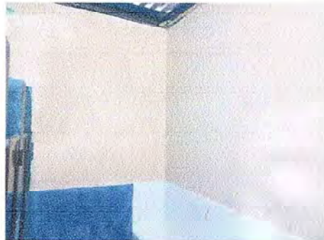
Foto 8: Se observa inicio de aplicación de pintura
