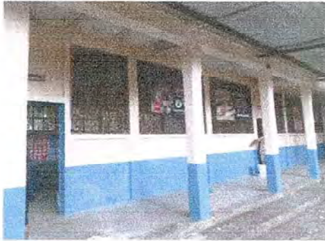
Foto 19: Se observa con primera mano de pintura
