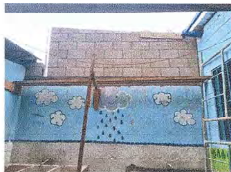
Foto 10: Se observan trabajos de mejora en muro
