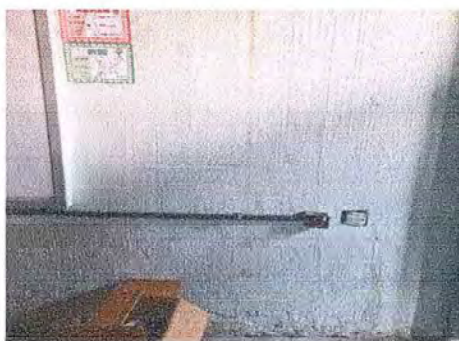
Foto 15: Se observa sistema eléctrico en reparación con el entubado y cableado nuevo
