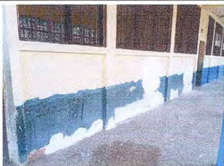
Foto 17: Se observa pared en reparación de cernido
