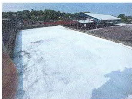
Foto 18: se observa trabajos de impermeabilizado de losa
