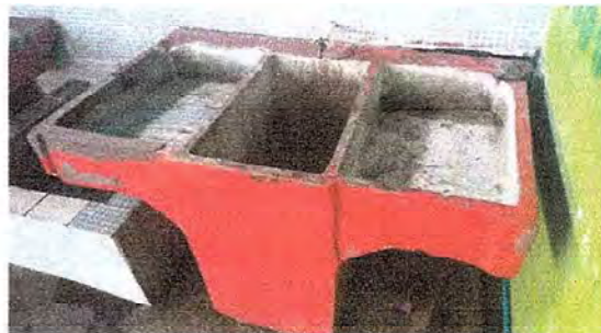
Foto 14: Se observa pila en mal estado e inestable.
