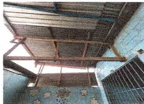
Foto 12: Se observa estructura de madera en mal estado.
