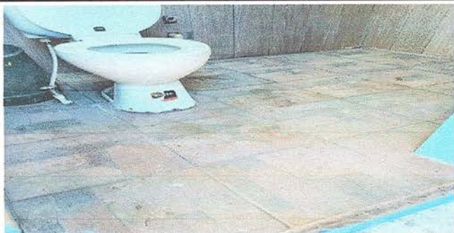
Foto 7: Se observa el piso de los modulos del sanitario finalizado.
