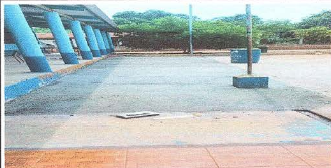
Foto 8: Se observa el pavimento finalizado.
