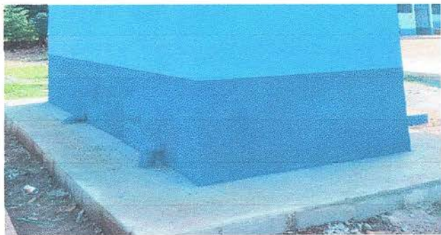
Foto 5: Se observa la colocación de banqueta de concreto en el módulo del baño finalizado.
