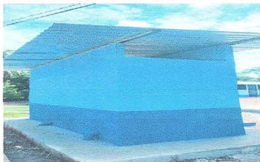
Foto 4: Se observa la colocación de la ventana en el modulo de los baños ya finalizado.
