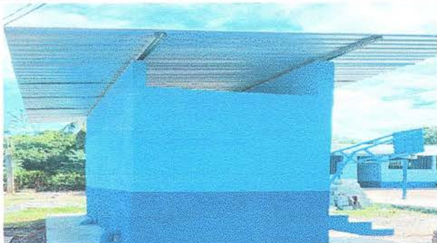
Foto 3: Se observa el cambio de lámina y estructura metálica finalizada.
