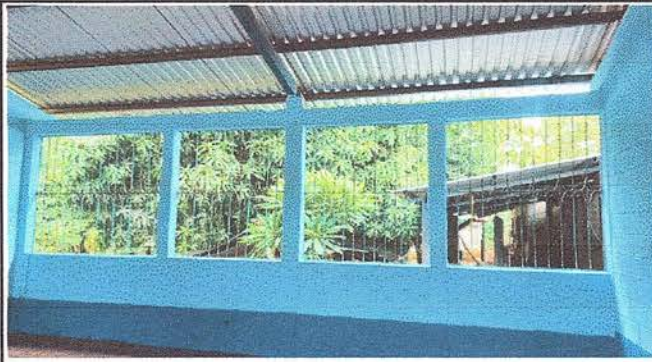
Foto 10: Se observa los muros de los modulos 1 y 2 finalizados.
