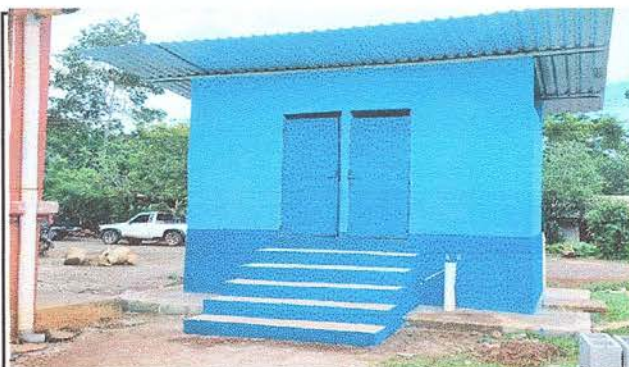
Foto 6: Se observa la sustitución de las gradas del servicio sanitario finalizado.
