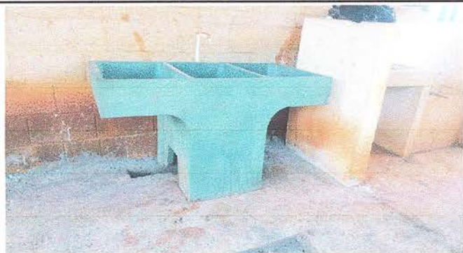
Foto 9: Se observa pila ya finalizada.
