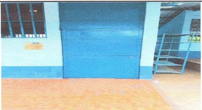
Foto 11: Se observa la puerta metalica del módulo de aula 2 finalizada.
