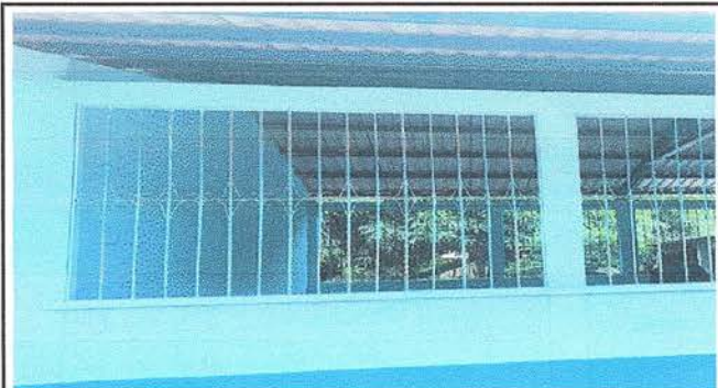
Foto 12: Se observa los balcones de metal de módulo de aulas 2 finalizado.
