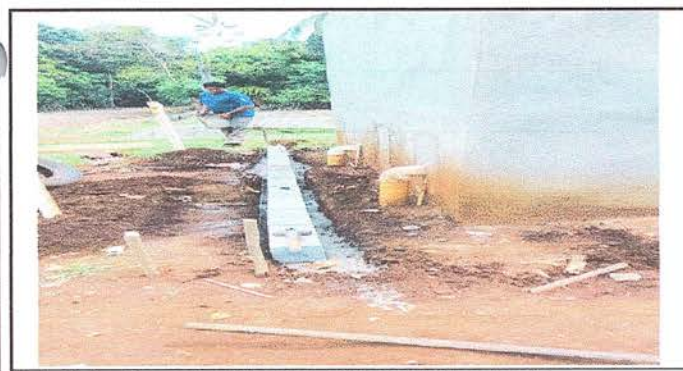
Foto 5: Se observa la colocación de banqueta de concreto.
