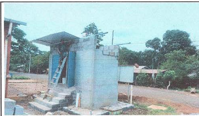
Foto 4: Se observa la colocación de la ventana.
