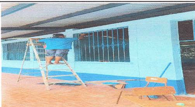
Foto 12: Se observa el mantenimiento de los balcones metalicos de las aulas del módulo 2.
