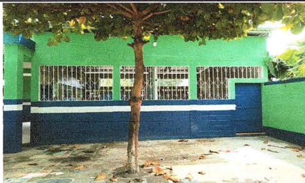
Foto 1: Se observa la finalización en el módulo de aulas 1 a remozar en techo, muros, ventanas, piso y puertas
