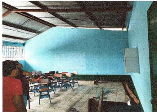
Foto 8: Se observa el proceso que el agua de lluvia que se filtra por el mojinete, está afectando los muros.
