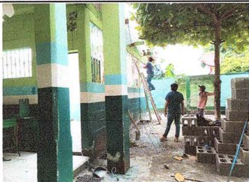
Foto 1: Se observa el proceso que el módulo de aulas 1 a remozar en techo, muros, ventanas, piso y puertas
