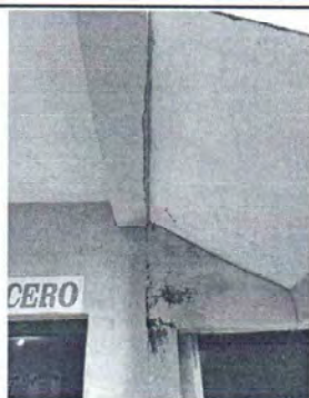
Foto 9: Se observa humedad y desprendimiento de repello en el módulo de gradas
