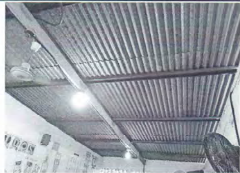
Foto 2: Se observa que módulo de aulas 1 tiene la lámina y estructura de metal en mal estado, urge su sustitución. Además es necesario sustituir el sistema eléctrico, el cual se dañará al desmontar la cubierta.
