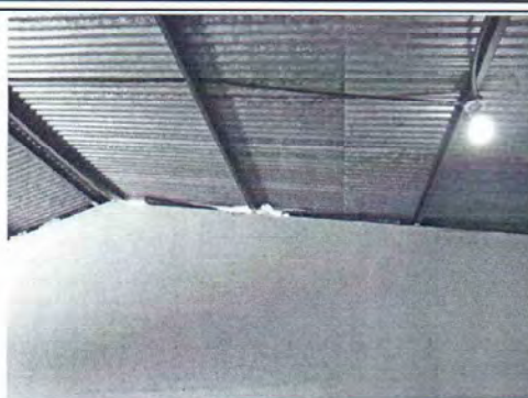
Foto 8: Se observa que el agua de lluvia que se filtra por el mojinete, está afectando los muros.
