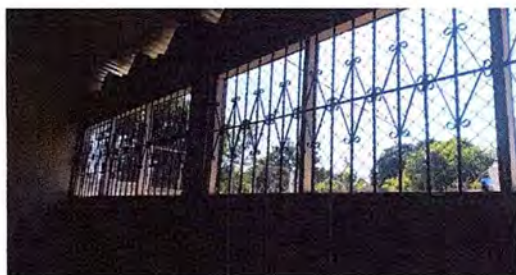
Foto 11: Se observa la finalización e instalación de los balcones en cada uno de los salones.
