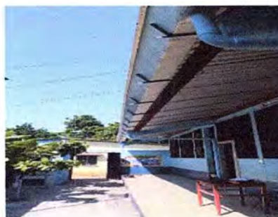
Foto 12: Se observa la colocación y finalización de los trabajos en los canales de cada uno de los módulos.
