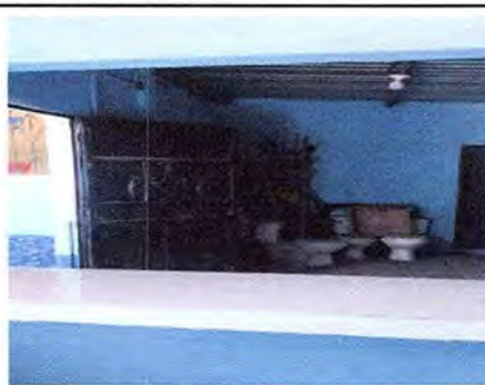
Foto 8: Se observa la finalización del tallado de ventana y de desayunoador para despacho alimentación para grados pequeños
