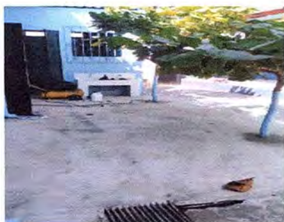
Foto 9: Se observa la finalización de la torta de cemento.
