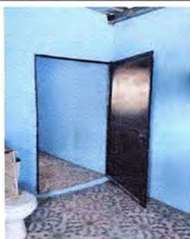
Foto 1: Se observa que la puerta para ingreso a los baños fue instalada y pintada
