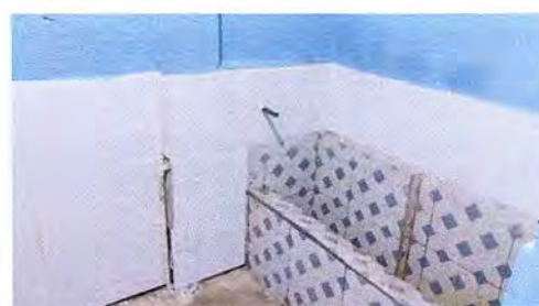
Foto 4: Se observa el trabajo terminado del azulejo en baños
