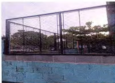
Foto 19: Se observa la finalización de trabajo de perimetral.
