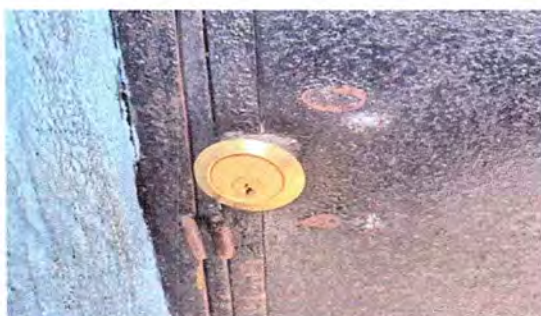
Foto 14: Se observa el trabajo terminado en el cambio de chapas de los salones de clases.
