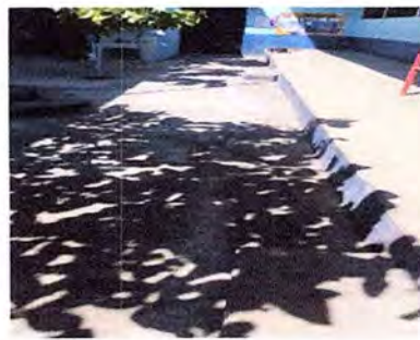
Foto 18: Se observan el trabajo terminado de cambio de tubería para el paso de aguas negras.
