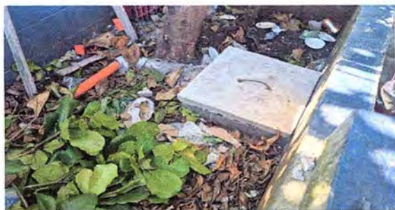
Foto 17: Se observa que la caja de registro está terminada así como la instalación de tubería para aguas negras.
