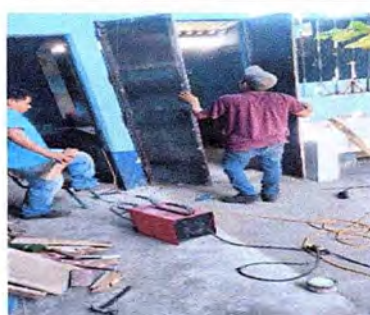
Foto 6: Tallado de puerta de ingreso a la cocina a la espera de ser pintada.
