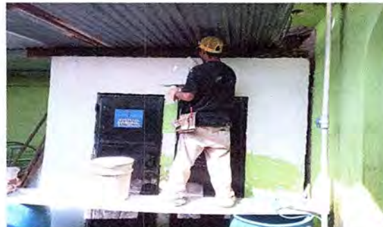
Foto 20: Se observa la primera mano de pintura en las paredes que necesitan ser pintadas.
