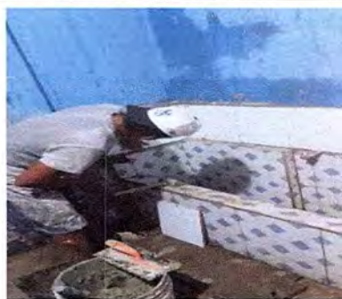
Foto 4: Realizando cambio de azulejos
