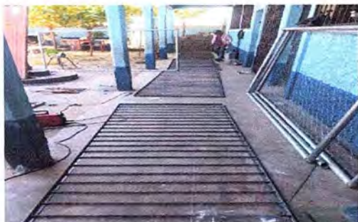
Foto 11: Se observan la realización de balcones para los salones.
