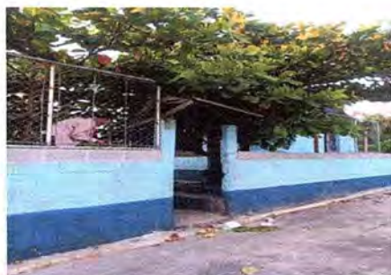
Foto 19: Se observa el cambio de la cerca perimetral.
