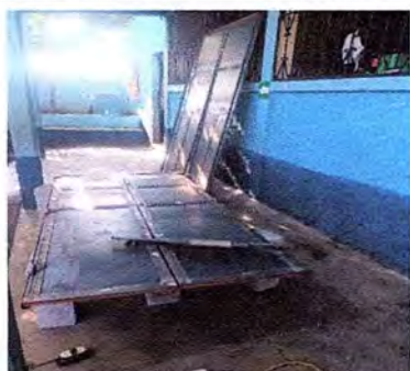
Foto 1: Están trabajando las para ingreso a los baños
