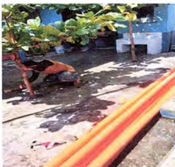
Foto 9: Se observa el tallado y la mejora del piso de concreto.
