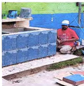
Foto 17: Se observa la instalación de la caja de registro e instalación tubería para drenaje de aguas negras.
