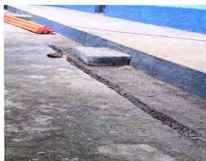
Foto 18: Se observan el cambio de la tubería para drenaje de aguas negras.
