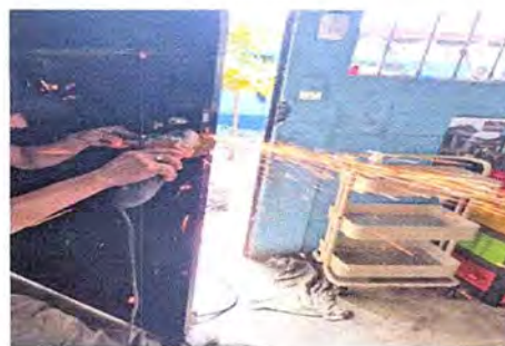
Foto 14: Se observa el cambio de chapas.
