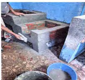
Foto 7: Se observa el trabajo de mejora en la estufa artesanal.
