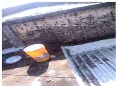
Foto 13: Se observa que se está realizando la impermeabilización para evitar la filtración en uniones de techo y pared.
