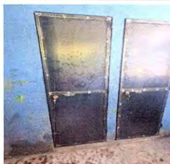
Foto 2: Tallado de puerta a servicios sanitarios, a la espera de ser pintadas.
