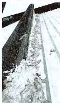
Foto 13: Se observa filtración en uniones de techo y pared.
