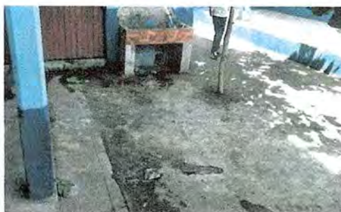
Foto 9: Se observa que el piso de concreto se encuentra en mal estado.
