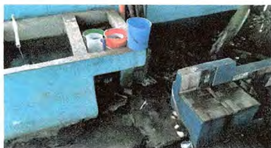
Foto 17: Se observa pila sin caja de registro ni drenaje de aguas negras.
