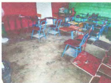
Foto 1: Se observa el piso deteriorado en todas las salones de clase de la escuela.
