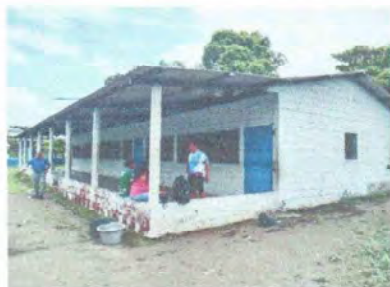
Foto 3: Se observan los salones y el exterior de las aulas, con la pintura desgastada.
