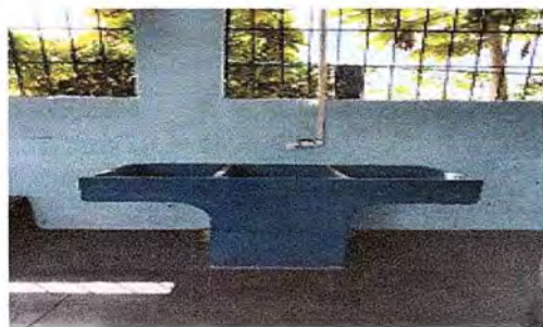
Foto 5: Se observa la finalización de la pila.
