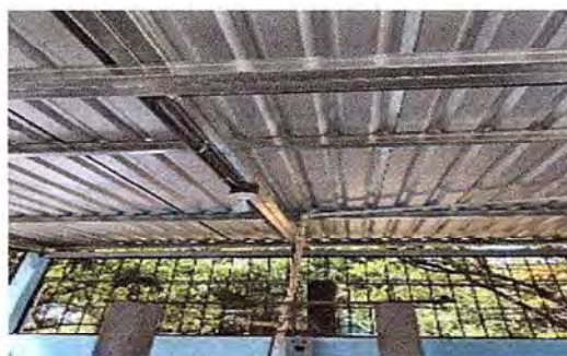
Foto 2: Se observa la finalización del cambio de la estructura de soporte.
