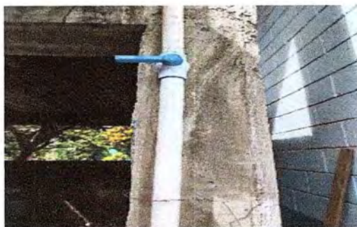
Foto 16: Se observa de la finalización de reparación de la tubería principal de agua potable.
