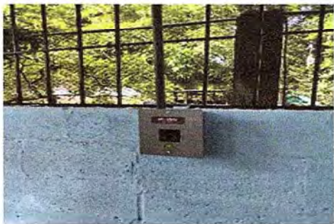
Foto 7: Se observa la finalización del sistema eléctrico.
