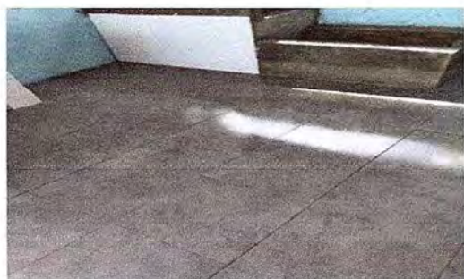
Foto 3: Se observa la finalización del piso.
