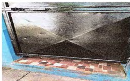
Foto 15: Se observa la finalización la reparación de las puertas.
