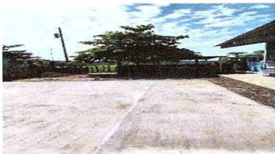
Foto 13: Se observa la finalización de la torta de cemento en el patio.
