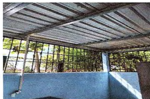
Foto 4: se observa la finalización de la colocación de balcones.
