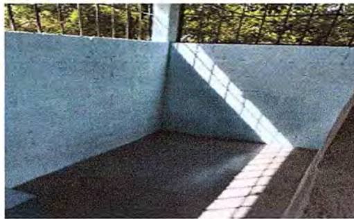
Foto 8: Se observa la finalización de la aplicación de pintura en interior y exterior.
