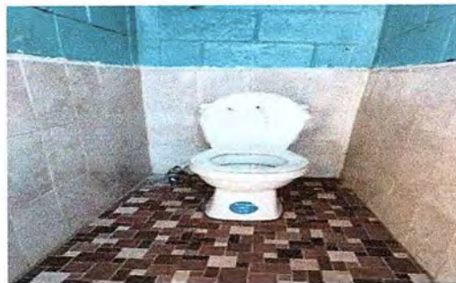
Foto 14: Se observa la finalización de la reparación del sanitario.
