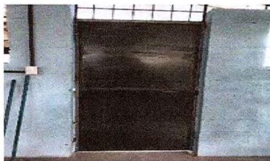
Foto 9: Se observa la finalización de la colocación de la puerta.
