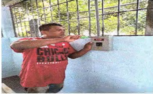
Foto 7: Se observa el proceso de cambio del sistema eléctrico.
