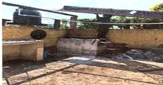
Foto 1: Se observa el proceso de sustitución de lámina.
