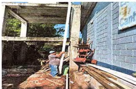
Foto 16: Se observa el proceso de reparación y cambio de tubería principal de agua potable.
