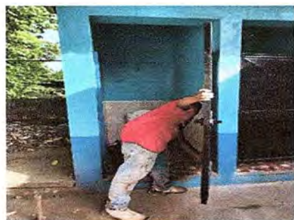
Foto 15: Se observa el proceso de reparación de puertas en servicios sanitarios.
