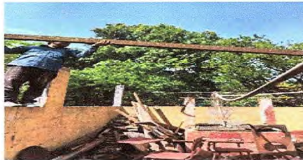
Foto 2: Se observa el proceso de sustitución de la estructura de soporte de madera por metal.
