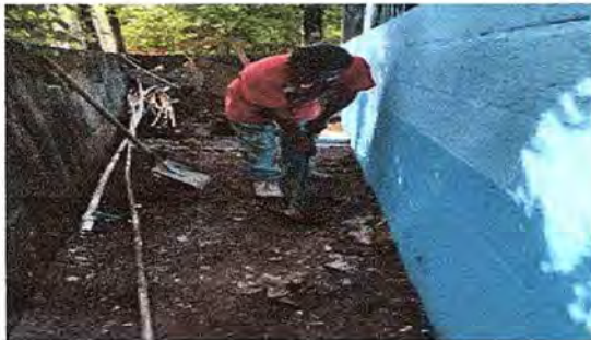
Foto 11: Se observa el proceso de cambio de tuberías donde pasara la línea de agua negras.
