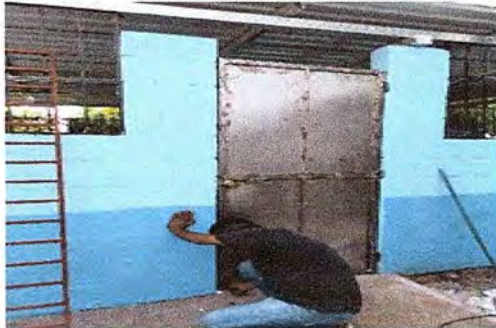
Foto 9: Se observa el proceso de cambio de la puerta.
