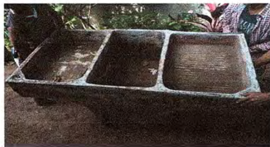
Foto 5: Se observa el proceso de sustitución de la pila.
