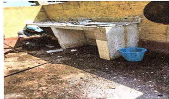
Foto 10: Se observa el proceso de sustitución de azulejo.
