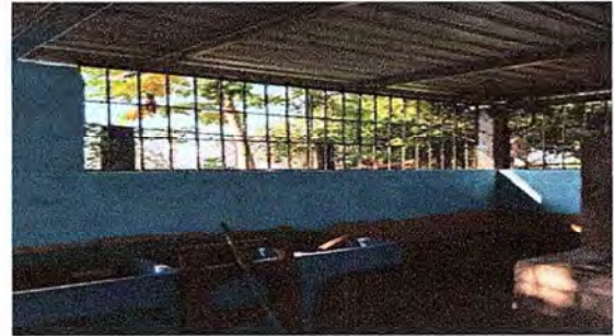
Foto 8: Se observa el proceso de aplicación de pintura interior y exterior.
