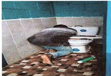
Foto 14: Se observa el proceso de reparación de la tubería dañada por fuga en inodoro.
