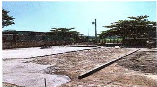
Foto 13: Se observa el proceso de aplicación de torta de concreto en patio.
