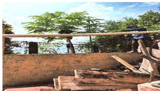
Foto 4: se observa el proceso de sustitución de malla por balcones.
