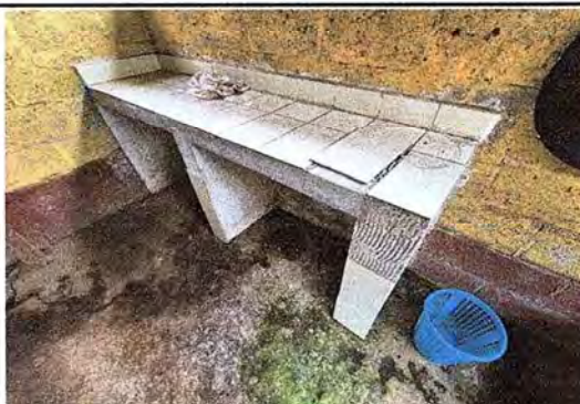
Foto 10: Se observa mueble de cocina con azulejo dañado.
