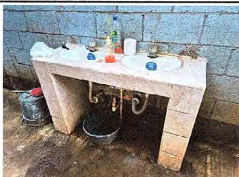
Foto 17: Se observan llaves deterioradas, problemas en el drenaje, problemas en el abasto de agua
