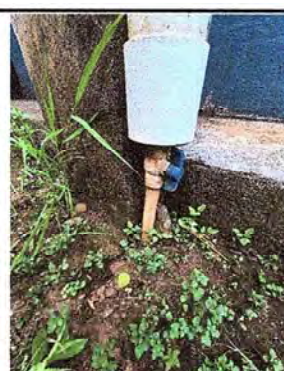
Foto 16: Se observa tubería principal de agua potable muy pequeña y con bajo caudal y presión en chorros
