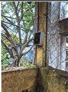
Foto 7: Se observa tablero de bomba en mal estado y sin iluminación y fuerza en el área de cocina.
