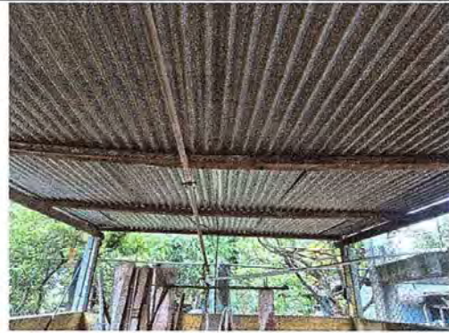
Foto 2: Se observa que el soporte de madera en cocina, está en mal estado
