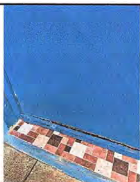
Foto 15: Se observan puertas con desprendimiento de lámina y corrosión
