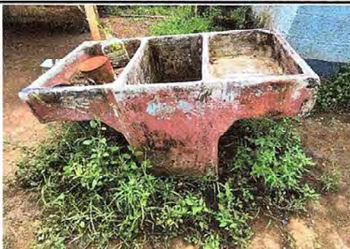
Foto 5: Se observa pila de cemento daña y no funcional
