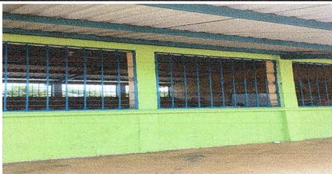
Foto 7: mantenimiento de balcones de metal finalizado .
