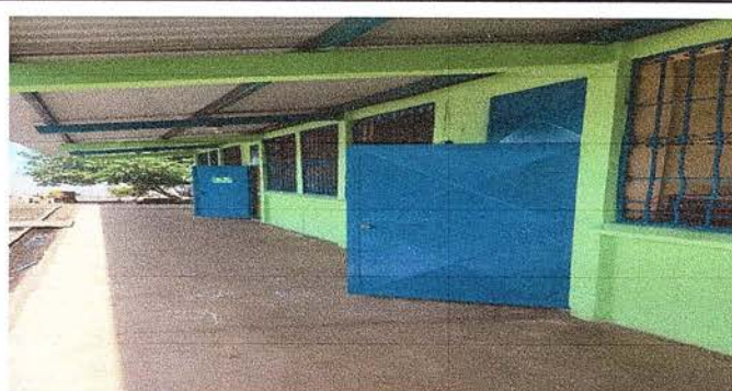
Foto 4: mantenimiento de puertas terminado.
