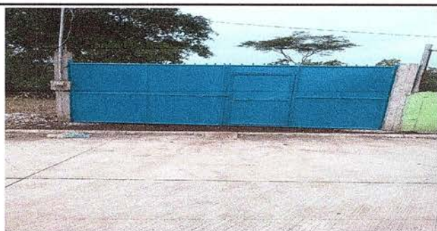
Foto 5: Suministro e instalacion de porton de metal finalizado.
