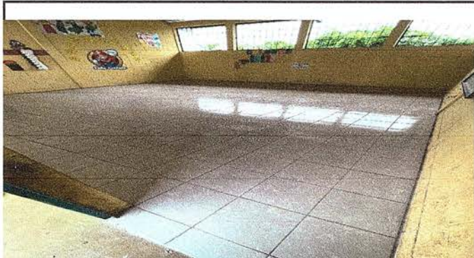
Foto 9: suministro de piso ceramico terminado
