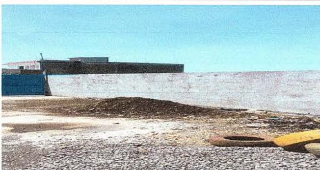
Foto 3: repello de muro finalizado.
