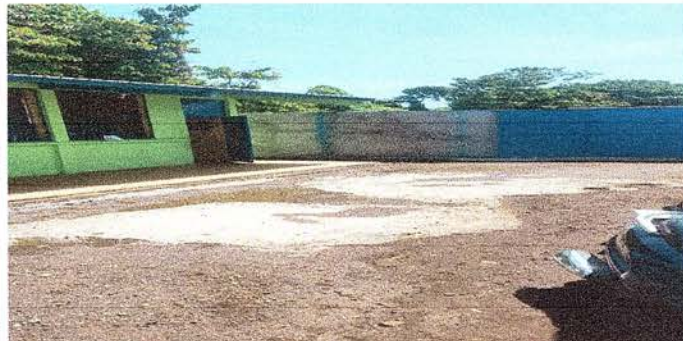
Foto 8: losa de piso se traslado al piso de cocina según acta numero 28-2024
