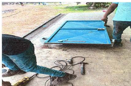
Foto 4: Mantenimiento de puertas en proceso.
