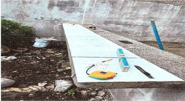
Foto 1: Instalacion de azulejo en top de cocina en proceso.
