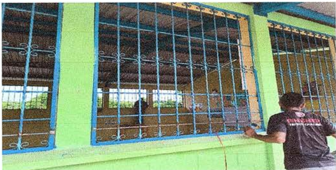
Foto 7: Mantenimiento a balcones en proceso
