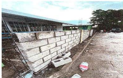
Foto 1: suministro e instalacion de muro de block en proceso .
