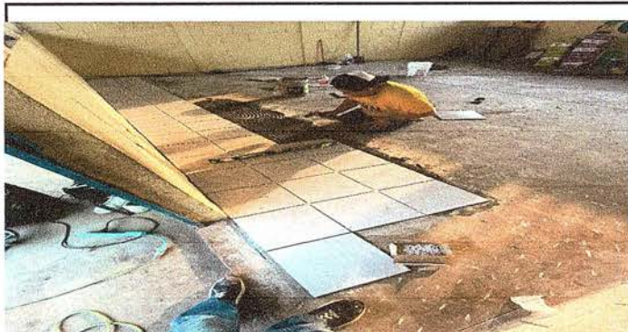
Foto 9: suministro de piso en proceso
