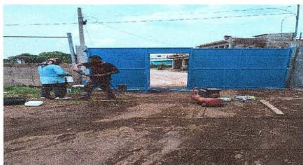
Foto 5: Mantenimiento de puertas en proceso.
