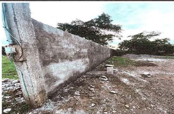
Foto 3: repello en muro en proceso
