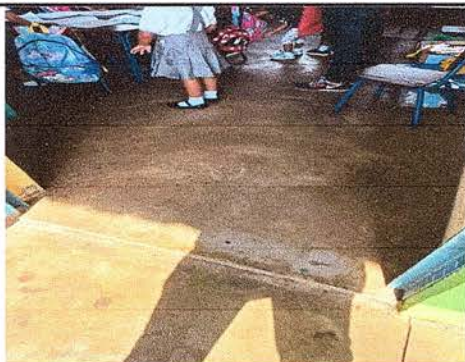
Foto 9: Las aulas solamente tienen una torta alisada, se le colocará piso cerámico.
