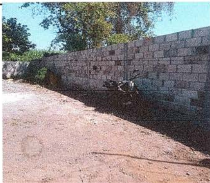
Foto 3: El muro perimetral del lado derecho no cuenta con repello, se prioriza hacer el repello en dicha pared.
