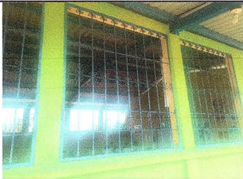
Foto 7: Se observa que los balcones necesitan mantenimiento en su estructura y deben ser asegurados ya que están sobrepuestos.
