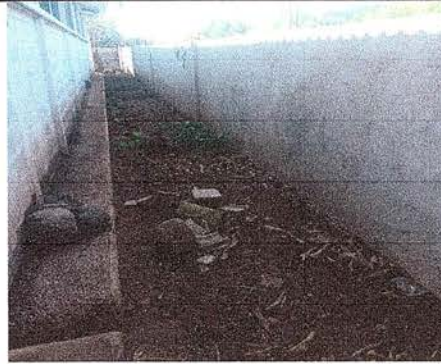
Foto 2: El muro perimetral de la parte trasera está bajo, por lo que necesita aumentar la altura, se considera que es necesario agregar 2 hiladas de block más.
