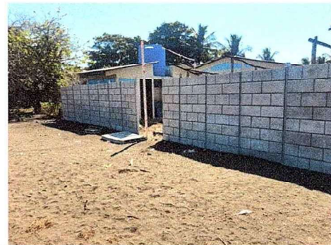
Foto 4: se observa el muro perimetral de muro prefabricado acabado.
