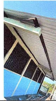
Foto 2: Se realizó el cambio de la estructura de soporte de madera.
