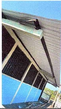
Foto 1: se realizó la sustitución de la lámina,
