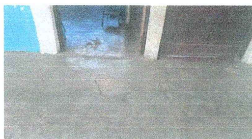
Foto 3: Se observa que el piso de cemento liquido necesita mejoras
