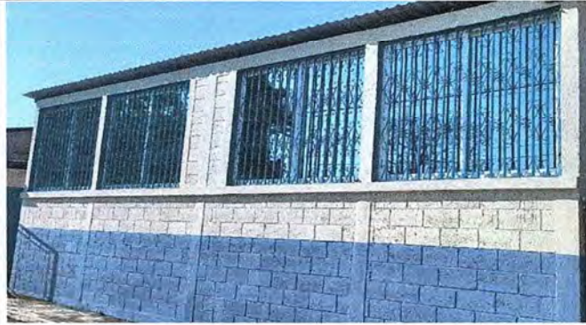
FOTO 1: SE OBSERVA LA FINALIZACIÓN DE LA INSTALACIÓN DE VENTANAS DE PVC.
