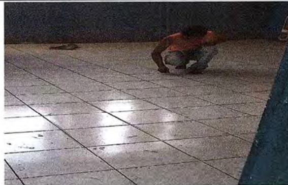
FOTO 2: SE OBSERVA EL PROCESO DE INSTALACIÓN DE PISO CERÁMICO.
