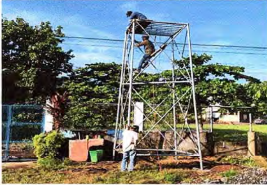
Foto 7: SE OBSERVA EL PROCESO DE LA CONSTRUCCIÓN DE TORRE DEL DEPÓSITO DE AGUA.
