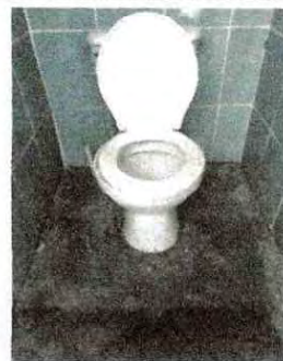
Foto 6: Se Observa la necesidad de cambio de los inodoro debido a la filtracion
