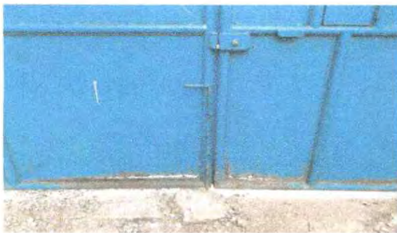
Foto 5: Se observa la necesidad de darle mantenimiento al porton debido al deterioro por corrosion
