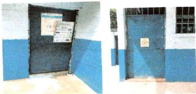
Foto 13: Se observa la necesidad de mejora en la pintura de las paredes de aulas
