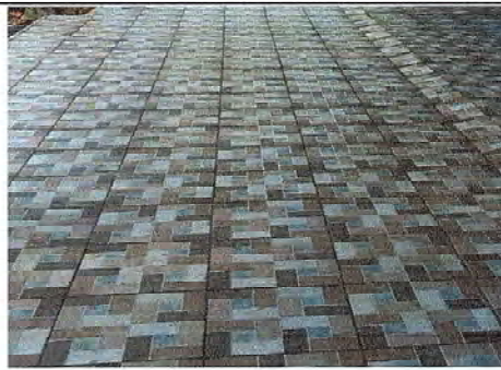
Foto 24: Se observa la finalización de piso cerámico
