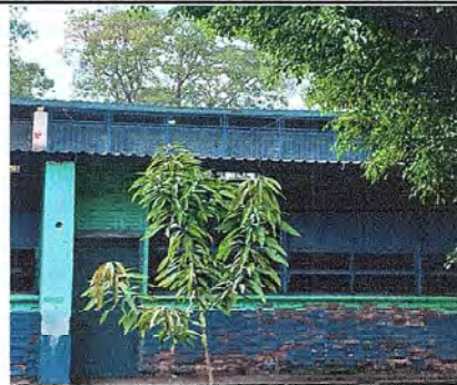
Foto 26: Se observa la finalización del reforzamiento
