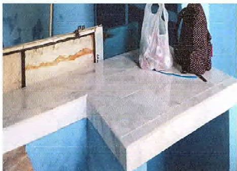
Foto 19: Se observa la finalización de la mesa de concreto
