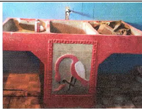
Foto 16: Se observa la finalización de la pila
