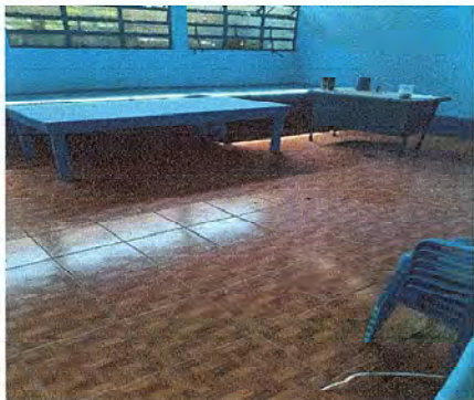
Foto 1: Se observa la finalización del piso ceramico
