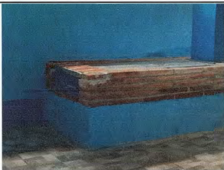
Foto 15: Se observa la finalización de la estufa
