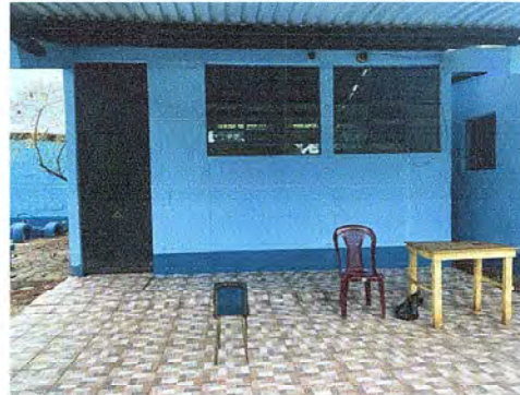
Foto 2: Se observa la finalización de ventanas
