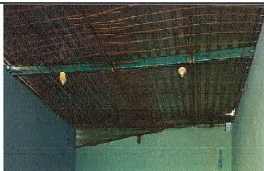
Foto 21: Se observa la finalización de reforzamiento de techo en la cocina
