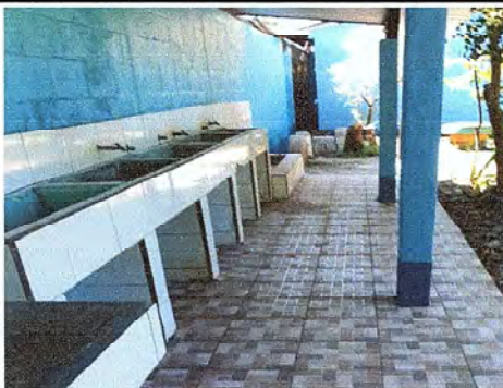
Foto 11: Se observa la finalización de piso cerámico
