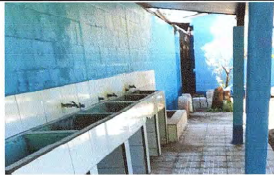
Foto 12: Se observa la finalización de la pintura de pared
