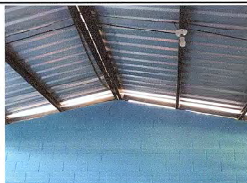
Foto 4: Se observa la finalización de costanera
