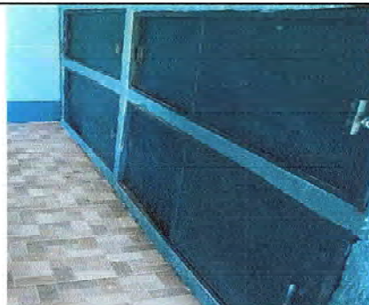
Foto 20: Se observa la finalización las puertas de almacenamiento
