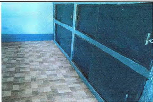
Foto 17: Se observa la finalización del piso cerámico de la cocina
