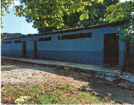
Foto 7: Se observa la finalización de caminamiento
