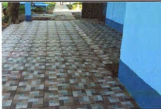
Foto 6: Se observa la finalización del piso ceramico
