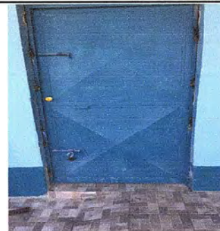
Foto 18: Se observa la finalización de la puerta de la cocina
