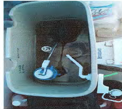
Foto 8: Se observa la finalización de accesorios de baño
