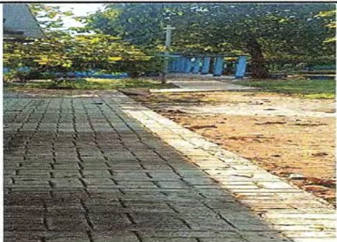
Foto 13: Se observa la finalización del caminamiento
