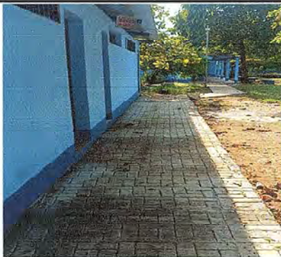
Foto 9: Se observa la finalización de la pintura de baño
