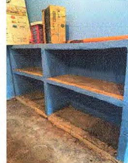
Foto 20: Se observa el proceso de instalación de las puertas en el almacenamiento
