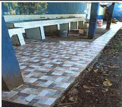
Foto 11: Se observa el proceso del ceramico
