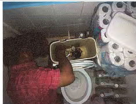
Foto 8: Se observa el proceso de instalación de accesorios de baño
