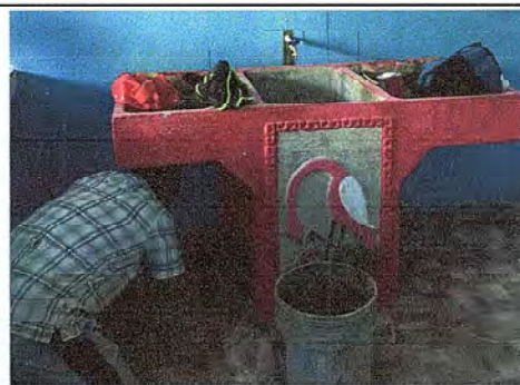
Foto 16: Se observa el proceso de instalación de pila
