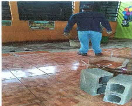
Foto 1: Se observa el proceso de piso cerámico
