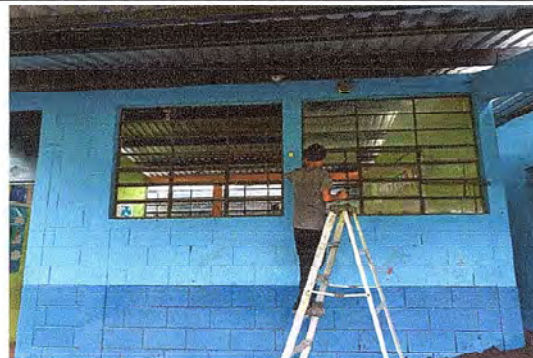
Foto 2: Se observa el proceso de mantenimiento de ventanas
