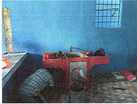
Foto 14: Se observa el proceso de instalación de tubería para agua potable de la pila
