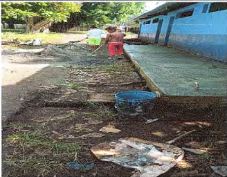
Foto 7: Se observa el proceso de el caminamiento
