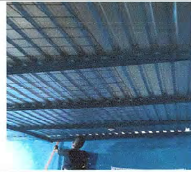
Foto 22: Se observa el proceso de reforzamiento
