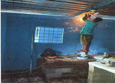
Foto 21: Se observa el proceso de la instalación de la electromalla
