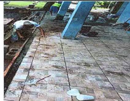
Foto 24: Se observa el proceso de piso cerámico
