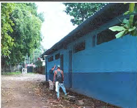
Foto 9: Se observa el proceso de la pintura
