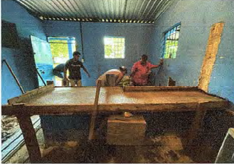
Foto 19: Se observa el proceso de la mesa de concreto en la cocina
