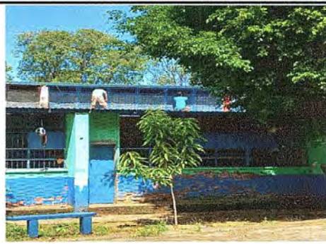
Foto 26: Se observa el proceso de reforzamiento
