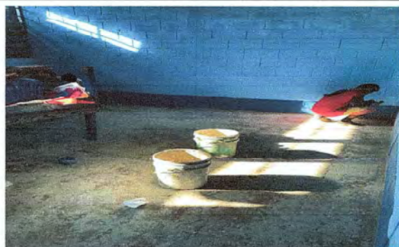
Foto 5: Se observa el proceso de pintura de pared
