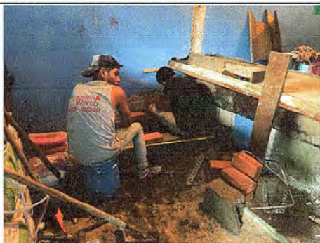
Foto 15: Se observa el proceso de instalación de estufa
