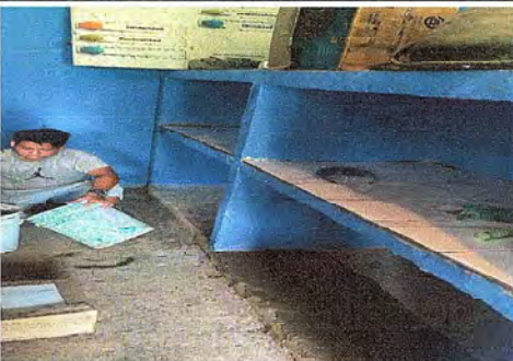
Foto 17: Se observa el proceso de instalación del piso cerámico en la cocina
