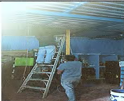
Foto 25: Se observa el proceso de reforzar el techo
