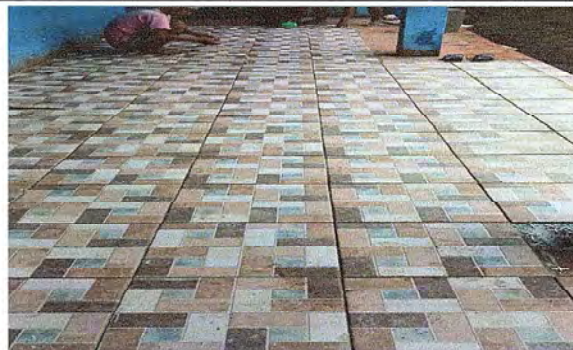
Foto 6: Se observa el proceso colocación de piso cerámico
