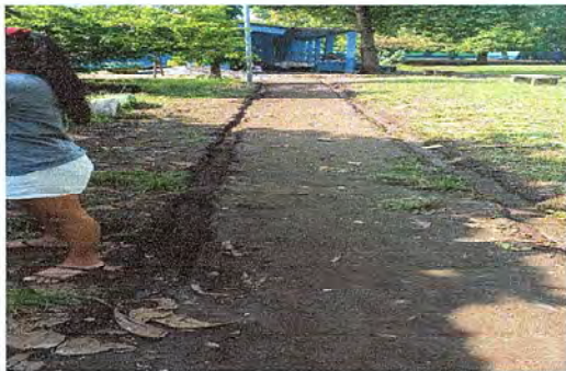
Foto 13: Se observa el proceso de encaminamiento
