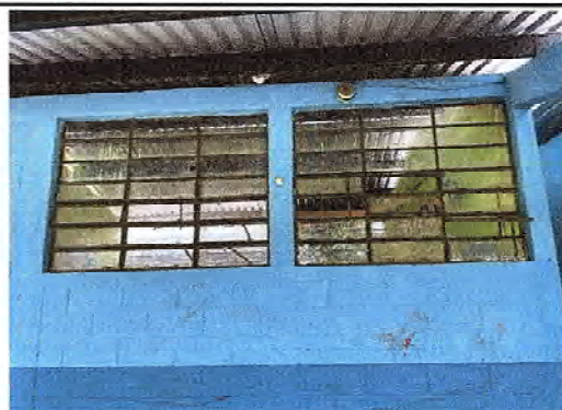
Foto 2: Se observa que cuenta con corrosión, y al abrirlas se quedan trabadas
