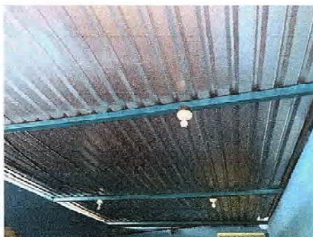
Foto 21: Se observa que es necesario reforzar el techo por motivo de los ladrones, tienden a levantar la lámina y meterse
