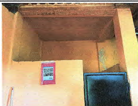
Foto 9: Se observa el mal estado de la pintura
