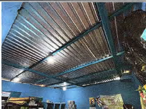
Foto 25: Se observa que es necesario reforzar el techo por motivo de que ladrones tienden a meterse levantando la lamina
