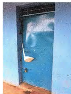
Foto 18: Se observa que la puerta no está reforzada se encuentra doblada y la chapa ya no sirve, en la parte interior tiene óxido
