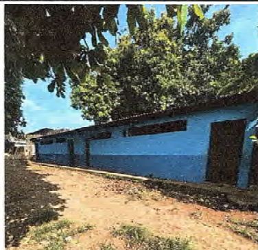
Foto 7: Se observa que el caminamiento se encuentra en mal estado y undido en algunas areas y el espacio es muy reducido
