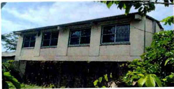
Foto 13: Sustitución de balcones culminado.
