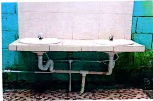
Foto 15: El trabajo de mantenimiento de desagüe y llaves de paso en los dos lavamanos culminado.
