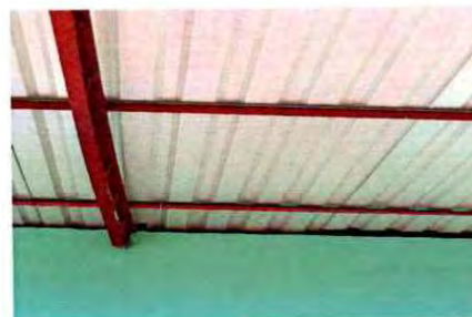
Foto 6: Las láminas se observan oxidadas y deterioradas por lo mismo se deben de sustituir.
