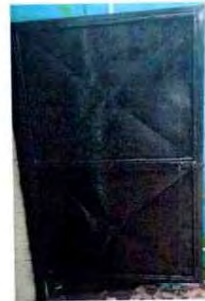
Foto 14: Mantenimiento de puertas de baños culminado.
